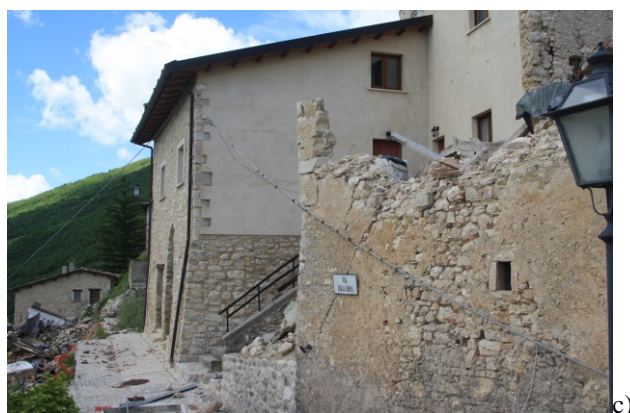
Figura 13. Aggregato costituito da due UMI 10 e 11: a) situazione al 2001 con UMI10 a sinistra e al centro, mentre parte della UMI11 è visibile sulla sinistra; b) vista di un lato differente della UMI11 sempre nel 2001 e c) situazione al 2016 dove in primo piano la UMI 11 è interamente crollata e sullo sfondo la UMI10 risulta consolidata e lesionata..
