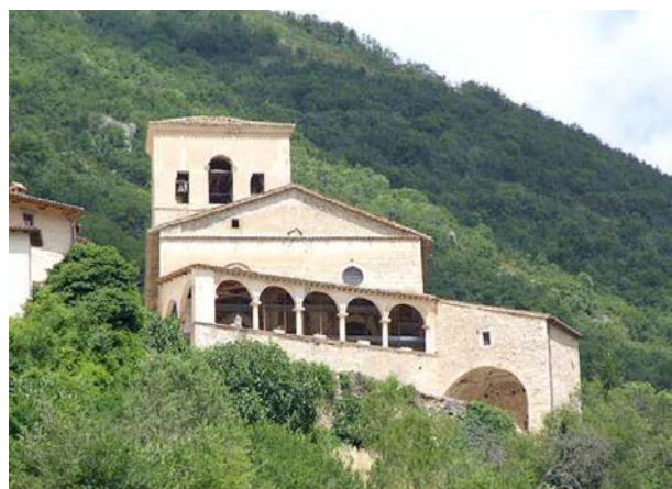
Figura 14. Vista della Chiesa di Sant'Andrea prima del sisma del 2016.
