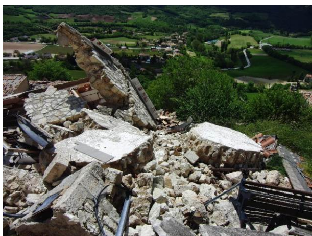
Figura 12. Edificio (UMI 8) a) riparato dopo il 1979 e il 1997 in uno scatto del 2001, e b) definitivamente crollato nel 2016
