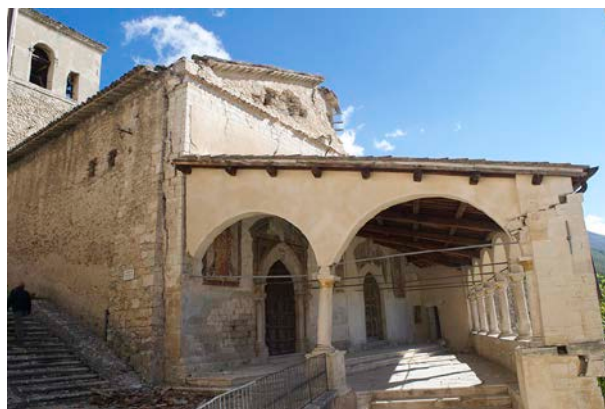
Figura 15. Vista della Chiesa di Sant'Andrea scattata tra la scossa del 26 e quella del 30 ottobre 2016. È chiaramente visibile il lavoro svolto dal portico antistante la facciata per reagire alla prima scossa ( http://umbrianotizieweb.it del 28.10.16).
