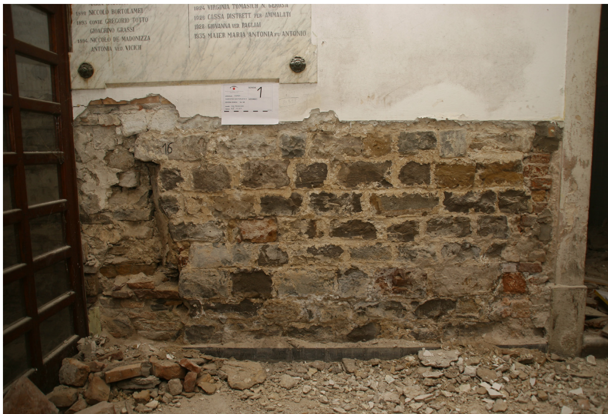
Fig. 7 [in alto] - La struttura regolare della parete meridionale della chiesa di S. Martino (Centro restauri ZVKDS, 2011)
