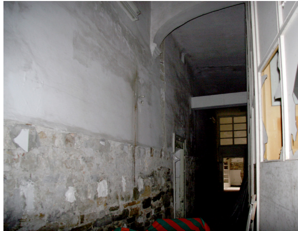
Fig. 36 - Vista della parete ovest e del soffitto. L'intonaco riveste sia i soffitti sia gli archi tra la prima e la seconda parte del corridoio.
