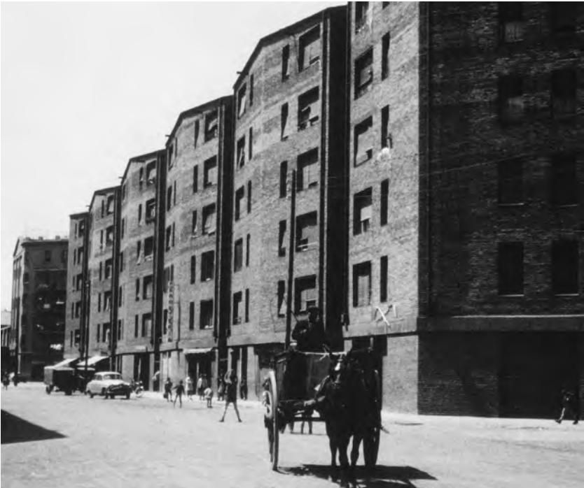
Oriol Bohigas y Josep M a Martorell. Bloque de viviendas en la calle Pallars, Barcelona, (1955-59).
