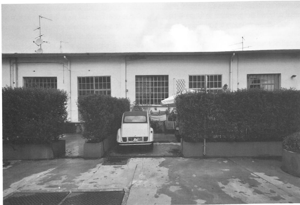
RIUSO RESIDENZIALE DI AREE DISMESSE (LOFT), EX GINORI, ORTICA / RESIDENTIAL RE-USE OF LOFTS, EX GINORI, ORTICA
