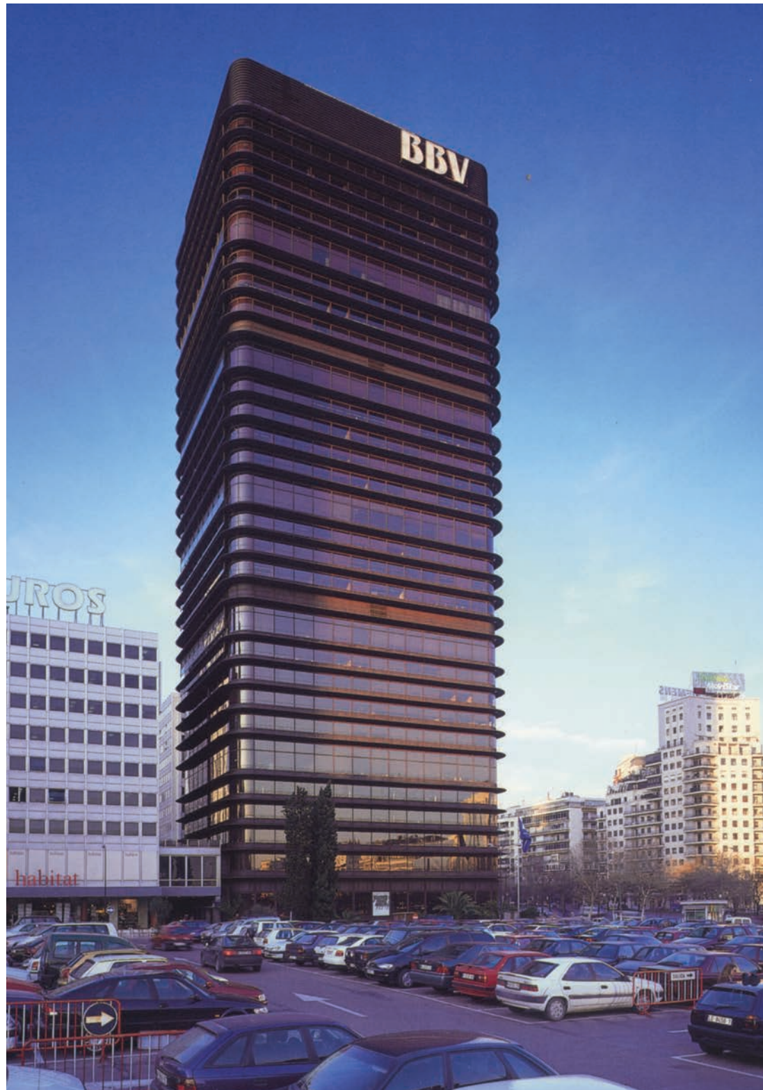
Carlo Gandolfi IL BANCO DE BILBAO DI FRANCISCO JAVIER SÁENZ DE OÍZA: "COME UNA NAVATA INDUSTRIALE"
