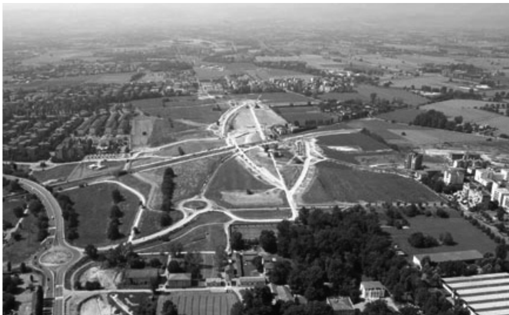
Reggio Emilia, Parco Ottavi, il grande parco in costruzione
