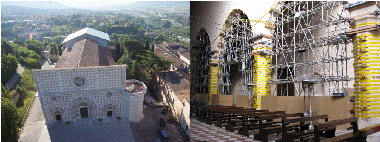
Figura 1. (a) Vista aerea della Basilica e della copertura provvisoria e (b) rinforzi provvisori navate
