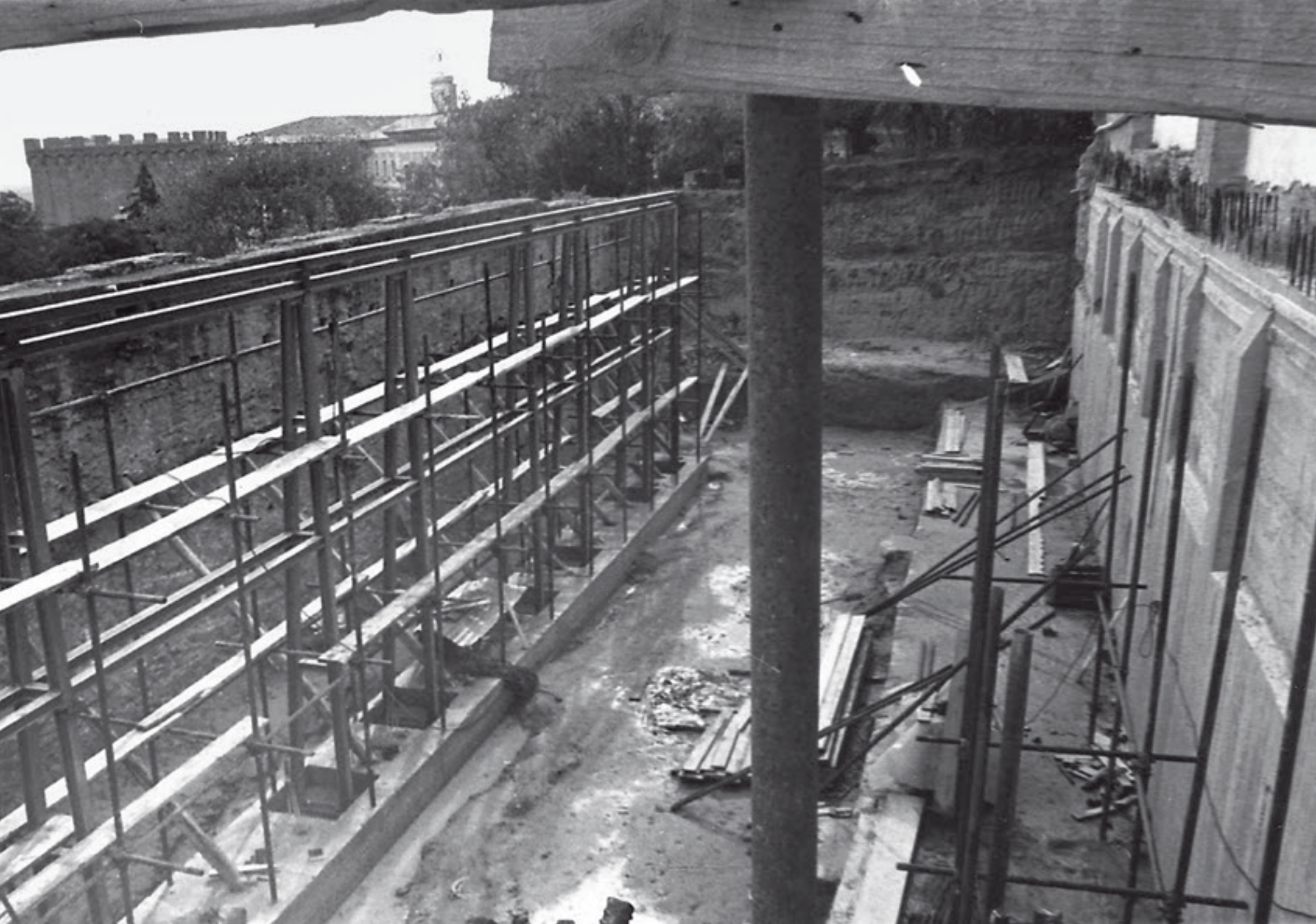
Il cantiere del nuovo edificio, 1982 circa, la struttura della grande vetrata (ASCdV).
