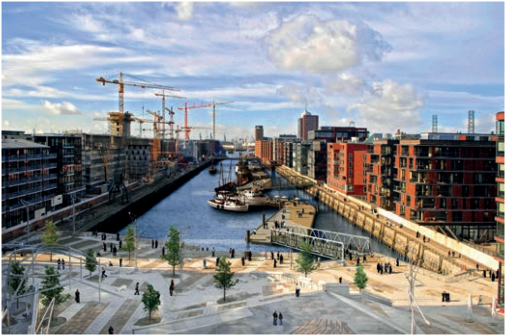
Amburgo, cantieri di rigenerazione urbana ad Hafencity.
