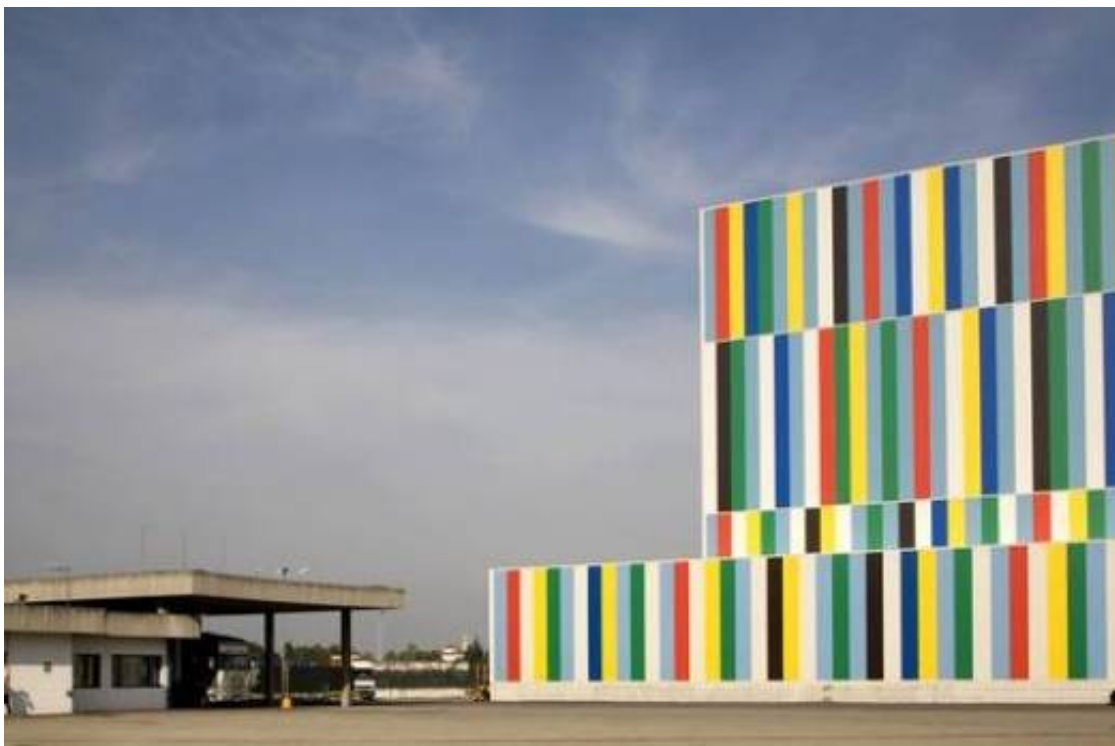
SAMAR - Magazzino autoportante meccanizzato per la logistica, Località Carazzina (LO) Progetto: Guidarini & Salvadeo - Stefano Guidarini, Pierluigi Salvadeo, 2007
