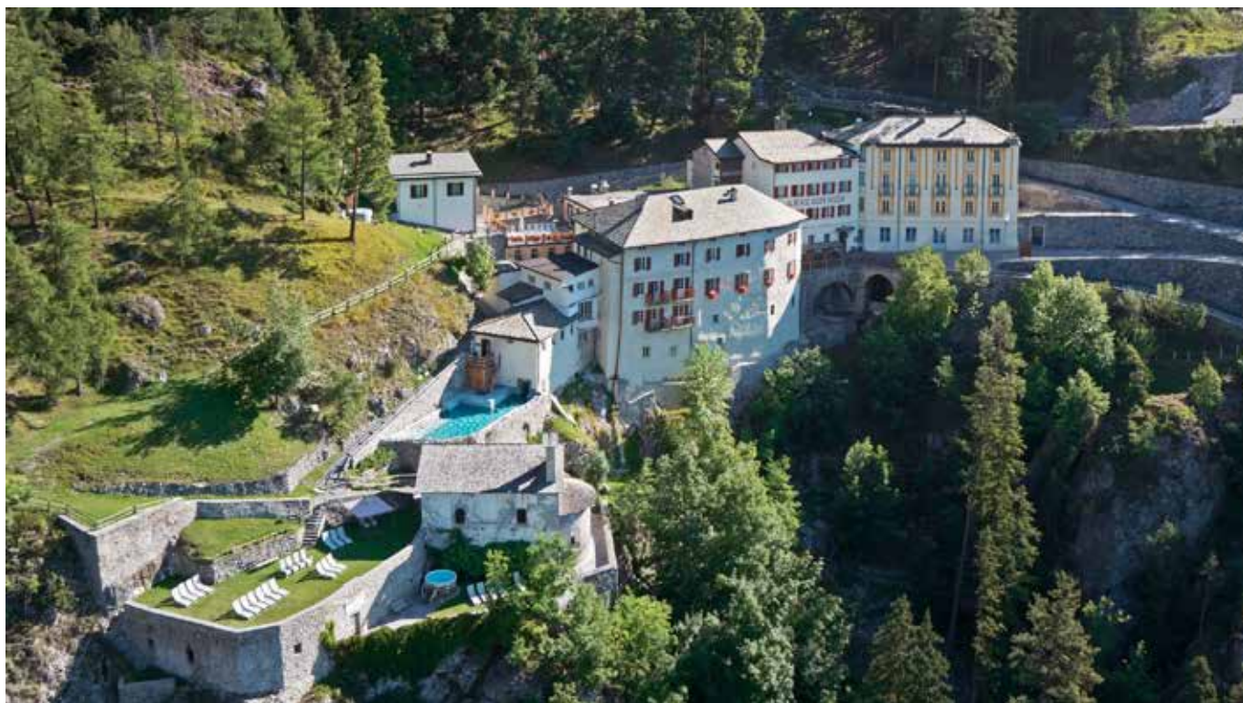
Vista d'insieme del complesso dei Bagni Vecchi di Bormio in un'immagine recente.
