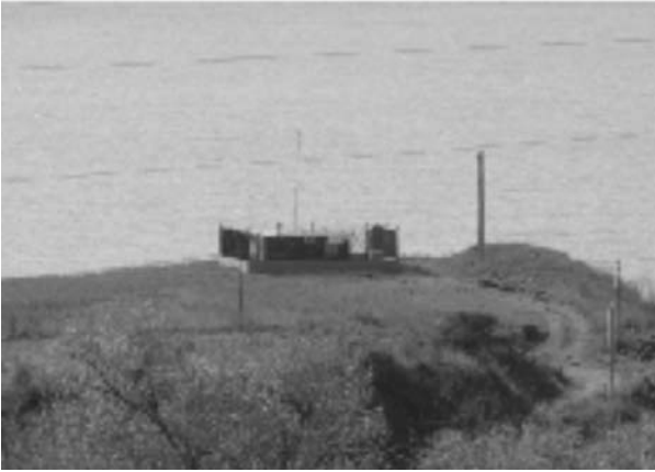
Figura 1: Stazione Sperimentale Marina (SSM) situata sulla costa tirrenica calabrese a 49 metri s.l.m. (N39°19'22" E16°02'44"), nel Comune di San Lucido (prov. di Cosenza).
