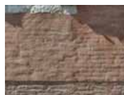
Fig. 42 - Nuovo intonaco in cocciopesto a strato sottile su muratura gotica.
