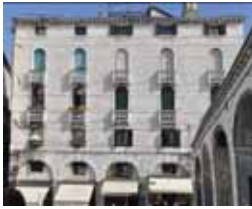
Fig. 58 - Integrazione pertinente di fronte unitario con marmorino liscio.
