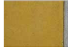
Fig. 15 - Intonaco a strati di impasti premiscelati con finitura gialla a superficie lisciata (XXI sec.).
