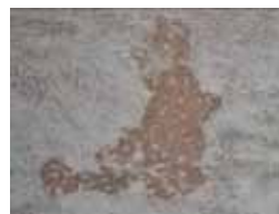
Fig. 36 - Integrazione a impasto e tinta affine al cocciopesto lucidato degradato.
