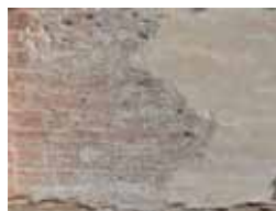
Fig. 33 - Integrazione parziale in accostamento con tinta neutra di intonaco a regalzier .
