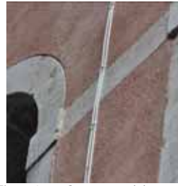
Fig. 48 - Spessore del nuovo intonaco che rispetta gli elementi classici del fronte.
