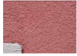
Fig.12 – Intonaco a strati di impasti premiscelati con finitura rosa a superficie frattazzata (XXI sec.).
