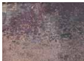
Fig. 8 – Intonaco in cocciopesto con finitura monocroma rossa lucidata (XVI sec.).
