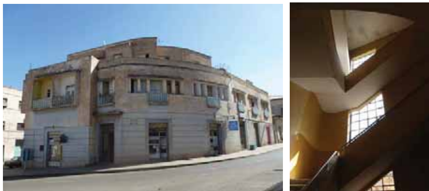
Fig. 1 - Asmara, edificio su Nakfa Avenue (prospetto esterno) e vista del vano scala con finiture originali.
