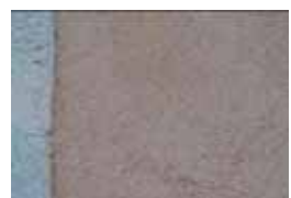
Fig. 44 - Nuovo intonaco in cocciopesto con lavorazione a lisciatura.
