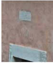
Fig. 47 - Spessore del nuovo intonaco che rispetta gli elementi del fronte di epoche diverse.
