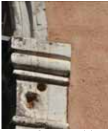
Fig. 46 - Spessore del nuovo intonaco che rispetta gli elementi gotici del fronte.
