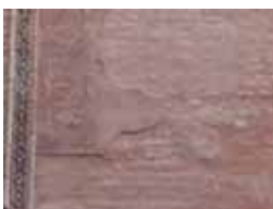
Fig. 39 - Integrazione a scialbatura con superficie grezza dell'intonaco in cocciopesto lucidato rimasto.
