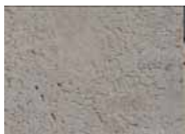
Fig. 38 - Integrazione a scialbatura affine all'intonaco in marmorino degradato.
