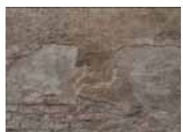
Fig. 40 - Integrazione parziale in sottosquadro dell'intonaco in cocciopesto eroso.
