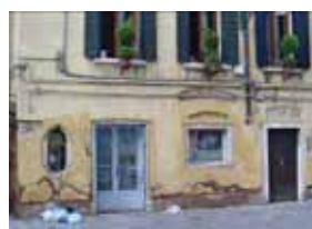
Fig. 27 - Evidenziazione impropria di elementi strutturali ad arco delle aperture (XXI sec.).
