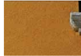
Fig. 14 - Intonaco a strati di impasti premiscelati con finitura gialla a superficie frattazzata (XXI sec.).
