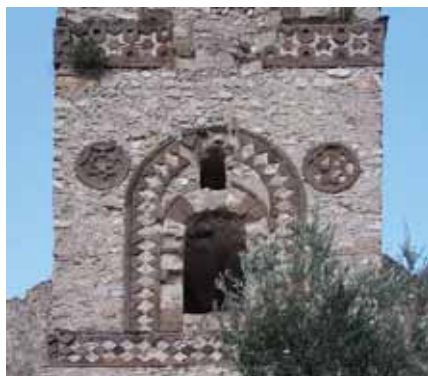
Figg. 19 - 20 - A sinistra: Lettere, campanile, particolare delle tarsie con triangoli e rombi. A destra: Minori, campanile della chiesa di S. Giovanni del Toro, particolare delle tarsie con triangoli e rombi in tufo giallo e grigio di Nocera.
