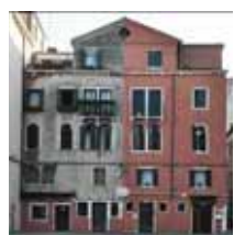
Fig. 25 - Fronte 'spezzato' da interventi non omogenei (XXI sec.).
