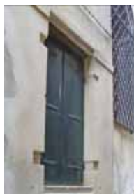
Fig. 30 - Spessori 'tecnologici' ma impropri ed errata lettura della cornice dell'apertura (fine XX sec.).
