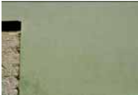
Fig. 13 - Intonaco a strati di impasti premiscelati con finitura verde a superficie lisciata (XXI sec.).
