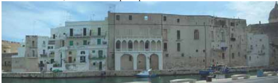
Fig. 1 - Monopoli. Cortine edilizie sul Porto Vecchio. Le superfici consumate; sfogliatura degli strati finali.
