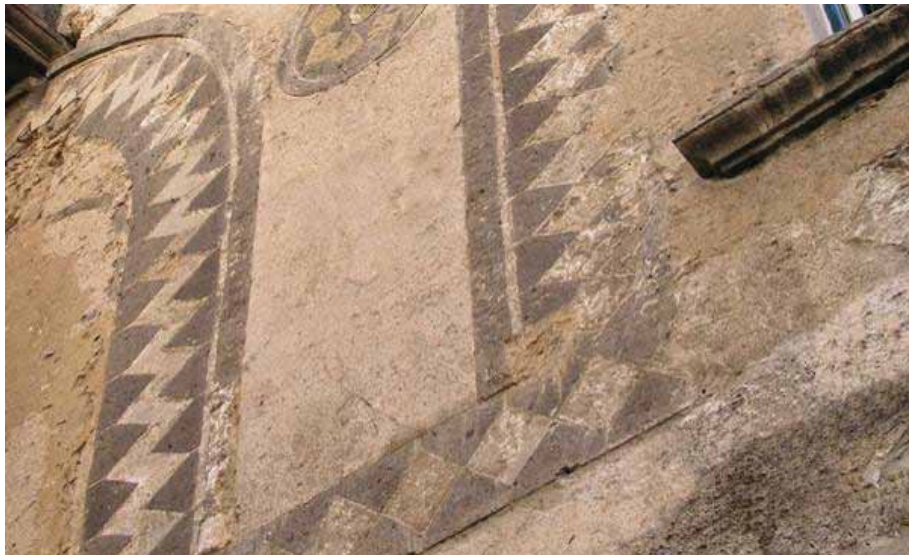
Fig. 24 - Sorrento, palazzo Veniero, tarsie murarie. Al di sopra della fascia orizzontale, con rombi di tufo giallo e triangoli di tufo grigio, vi sono delle decorazioni arcuate che incorniciano bifore, di cui si intravedono labili tracce.
