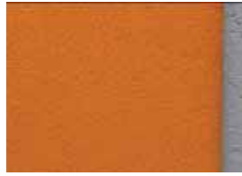
Fig.11 – Intonaco a strati di impasti premiscelati con finitura arancio a superficie frattazzata (XXI sec.).
