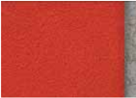
Fig.10 – Intonaco a strati di impasti premiscelati con finitura rossa a superficie frattazzata (XXI sec.).
