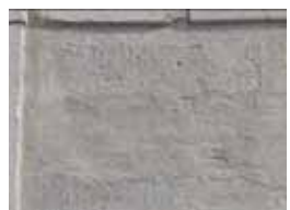
Fig. 37 - Integrazione ad impasto e lavorazione affine all'intonaco in marmorino monostrato degradato.
