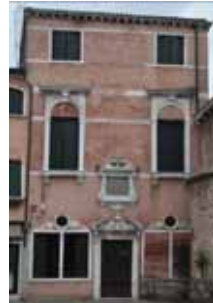
Fig. 57 - Integrazione pertinente di fronte unitario con coccopesto liscio.
