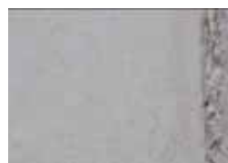
Fig. 45 - Nuovo intonaco in marmorino con lavorazione a lisciatura.
