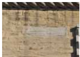
Fig. 34 - Intonachino a scialbatura di superficie gotica con tinta neutra.
