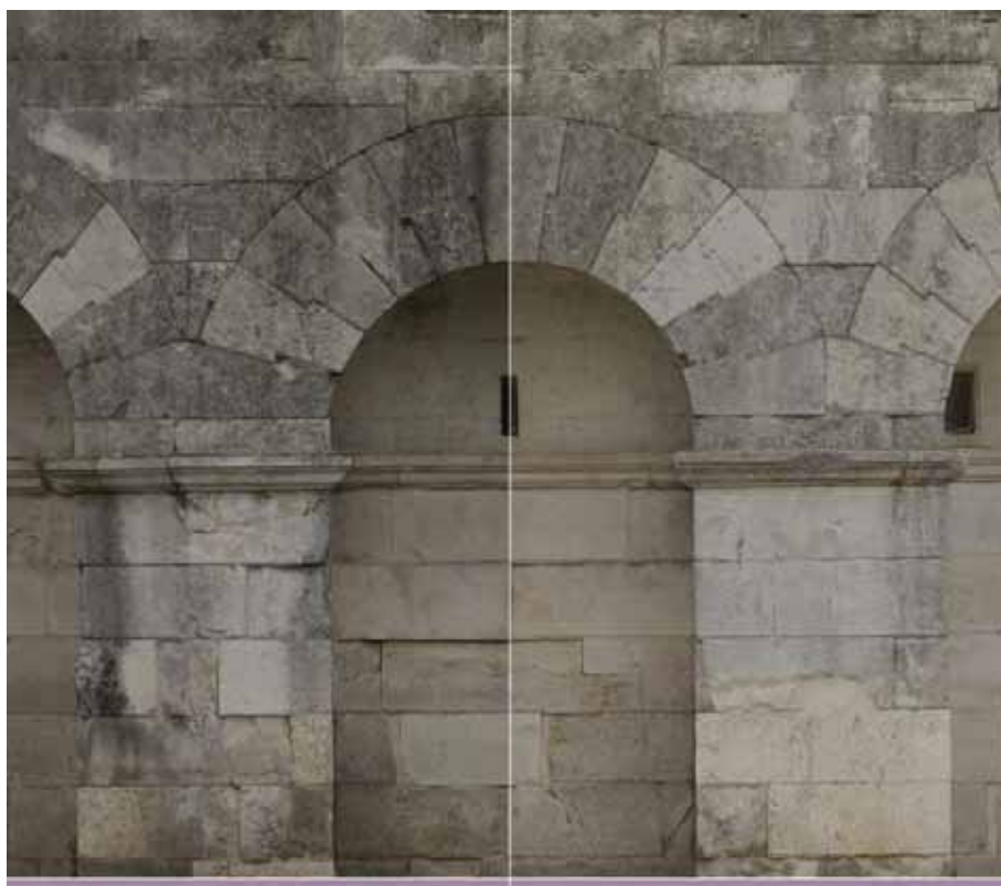
Fig. 7 – A destra: la texture del colore apparente. A sinistra: il risultato della procedura di shadow removal . La seconda texture presenta zone notevolmente meno scure nelle parti di occlusione rispetto a quella originale, pertanto la texture del colore apparente si è avvicinata alla texture del colore diffuso, garantendo al modello la possibilità di essere sottoposto a diverse condizioni di illuminazione rispetto a quella di partenza.
