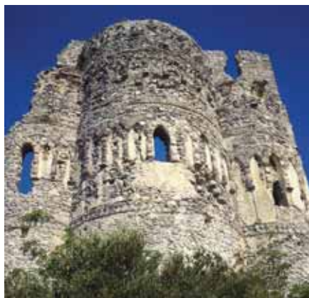
Figg. 21 - 22 - Scala, villaggio di Pontone, ruderi della chiesa di S. Eustachio. A sinistra, le superfici esterne delle absidi prima degli interventi di restauro; a destra, le superfici delle absidi dopo le alterazioni subite a seguito dei restauri del 1995-2002 (da G. Fiengo, A. Manco, pp. 84-85).
