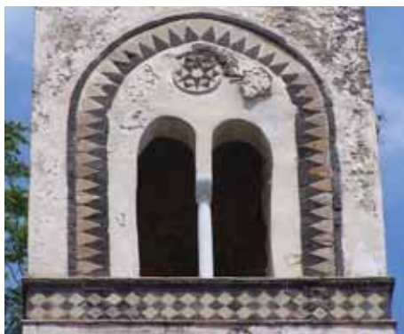
Figg. 19 - 20 - A sinistra: Lettere, campanile, particolare delle tarsie con triangoli e rombi. A destra: Minori, campanile della chiesa di S. Giovanni del Toro, particolare delle tarsie con triangoli e rombi in tufo giallo e grigio di Nocera.
