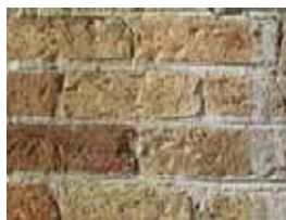
Fig. 1 – Muratura intenzionalmente a vista con stilatura dei giunti di malta (XIV sec.).
