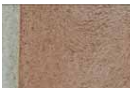
Fig. 43 - Nuovo intonaco in cocciopesto con lavorazione grezza.
