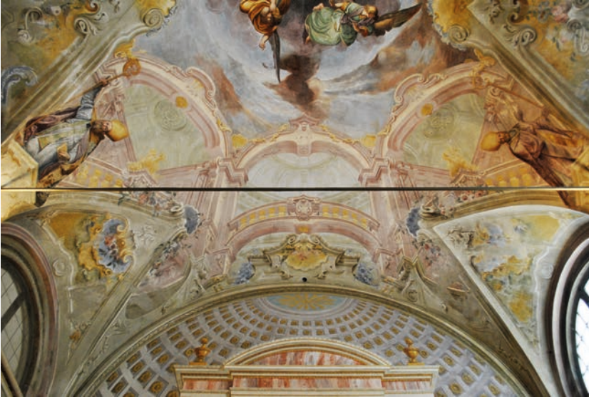
Fig. 20. Como, Cappella della Santissima Trinità, copertura a pennacchi dell'abside rettilinea, con ardiati sfondati prospettici.
