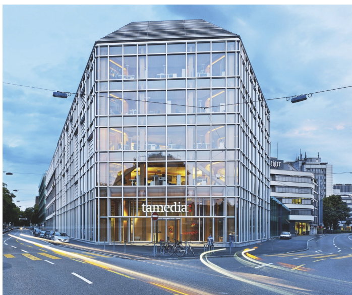
La facciata del quartier generale di Tamedia (Zurigo, Svizzera) è realizzata con il sistema Wiclina 75 SK di Wicona
