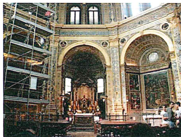
Fig. 4. Tempio Civico della Beata Vergine Incoronata, Lodi, cantiere-scuola.
