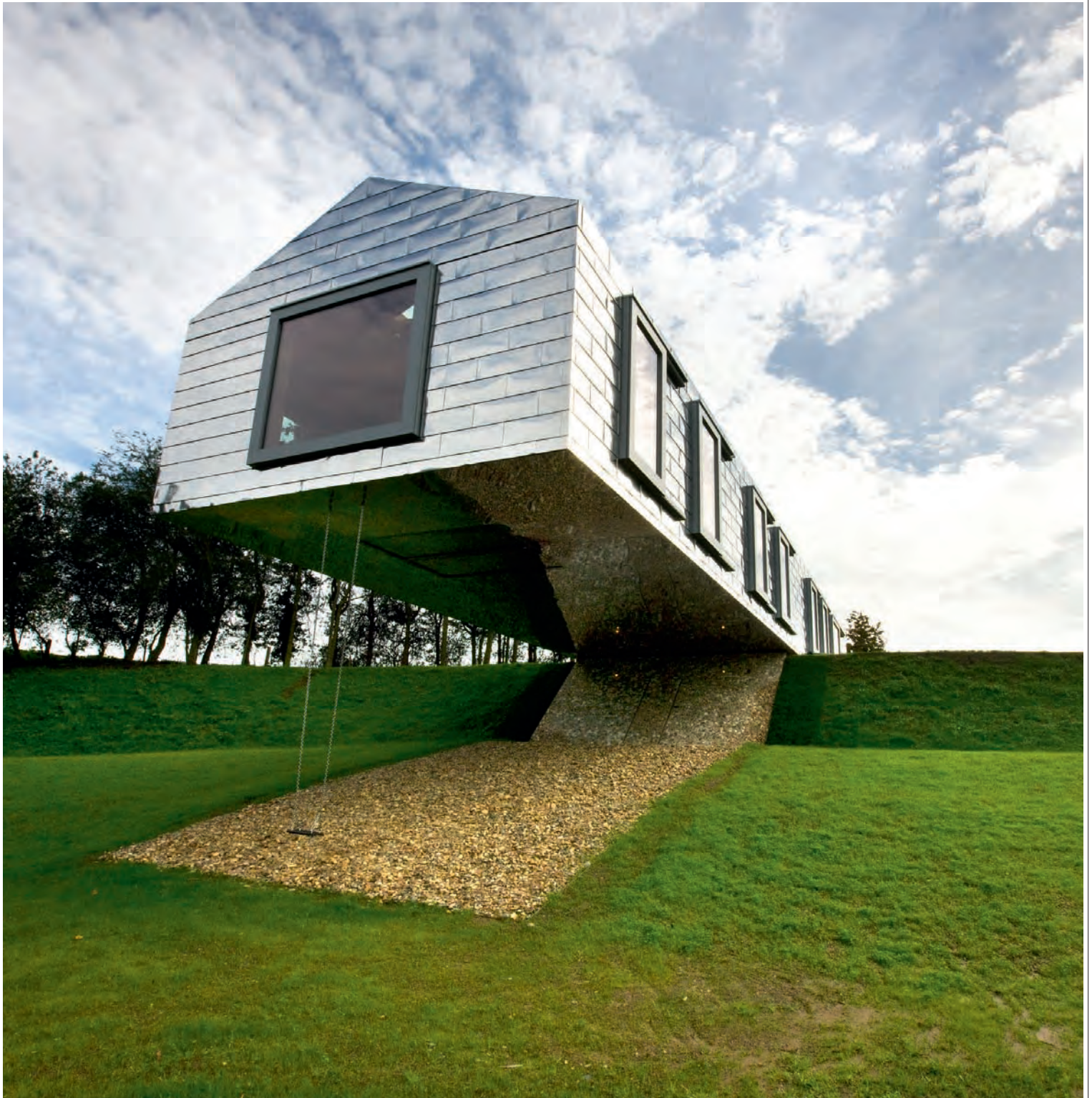
LE PARETI E IL TETTO SONO INTERAMENTE RIVESTITI DA LASTRE IN LAMIERA D'ACCIAIO, SECONDO UNA CONSUETUDINE LOCALE, CHE RIFLETTONO LUCI E COLORI DEL PAESAGGIO E DEI SUOI MUTAMENTI STAGIONALI.
