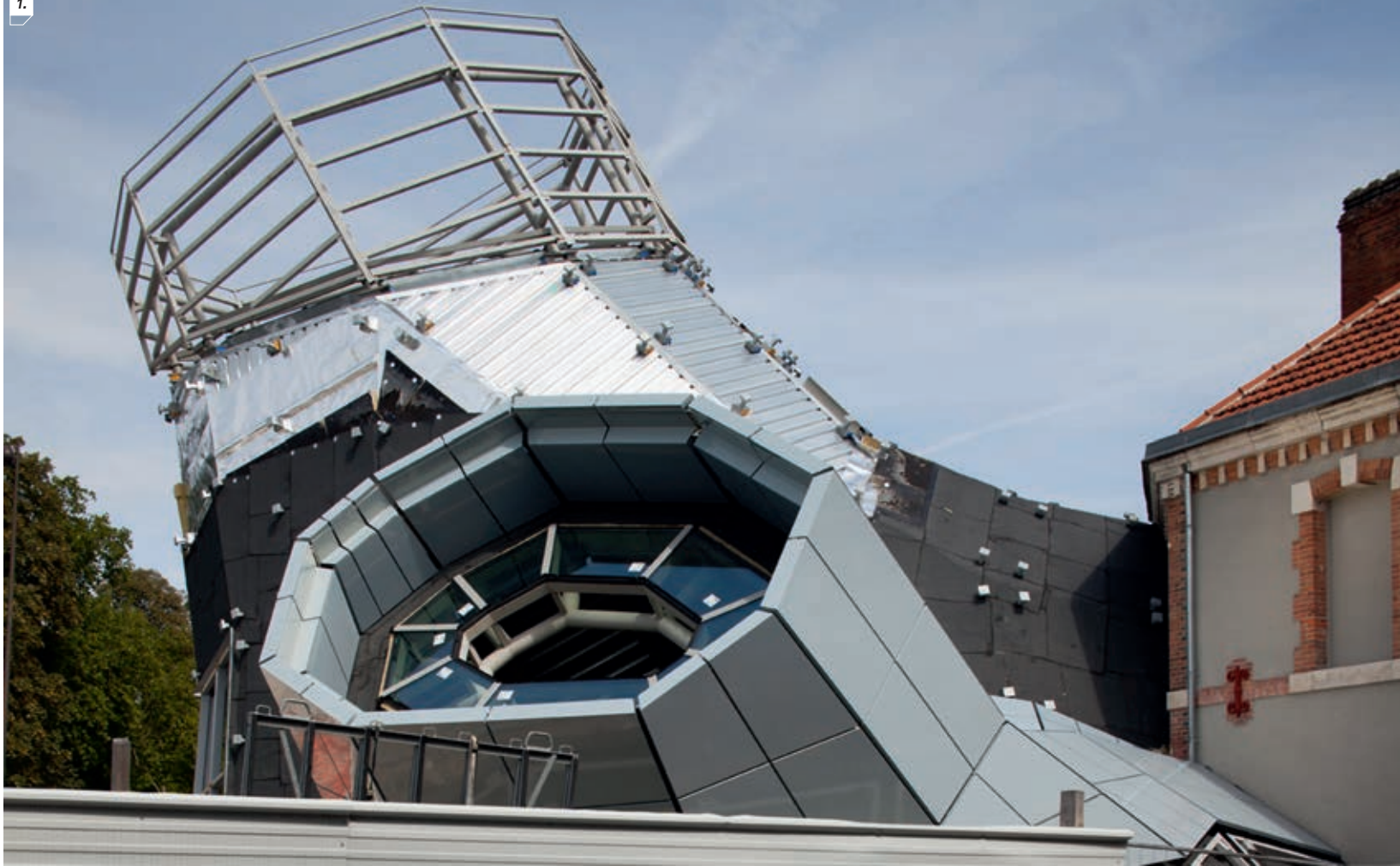
1. JACOB + MACFARLANE, CENTRO DI ARTE CONTEMPORANEA (FRAC), CENTRE ORLÉANS, FRANCIA, 2013, IN COSTRUZIONE
