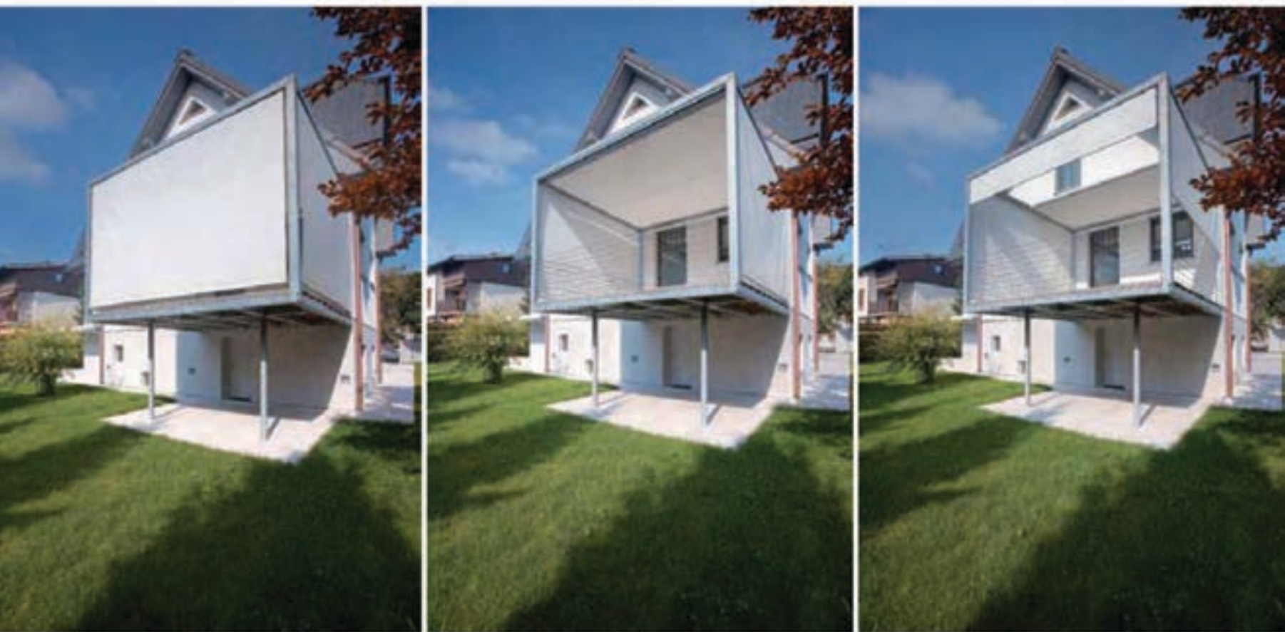
5 x 5 m , telles sont les dimensions de la pièce supplémentaires, un cube métallique qui change de configuration grâce à des parois et un plafond à éléments mobiles.
