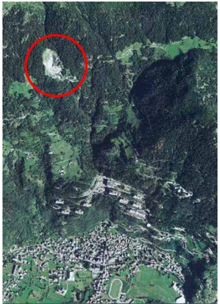
Foto aerea di Sondalo: in basso l'abitato; sopra l'ex villaggio sanatoriale; il cerchio rosso indica la cava di quarzo.
