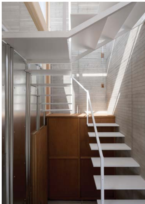
Fig. 21 - Casa a Ishikiri - Vista della scala in acciaio di collegamento tra piano terra e primo piano
