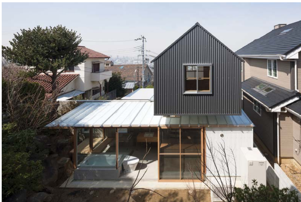
Fig. 16 - Casa a Ishikiri - Vista dell'edificio da nord
