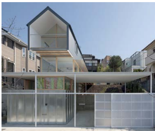
Fig. 2 - Casa a Ishikiri - Vista del fronte principale
