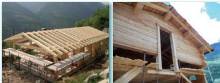
Figura 15 - Abitazioni in legno. Destra: costruzione in pannelli sandwich prefabbricati. Sinistra: abitazione costruita con legno grezzo squadrato (variante del tipo Blockhaus). [Fotografie: segheria Mariana Franco]
