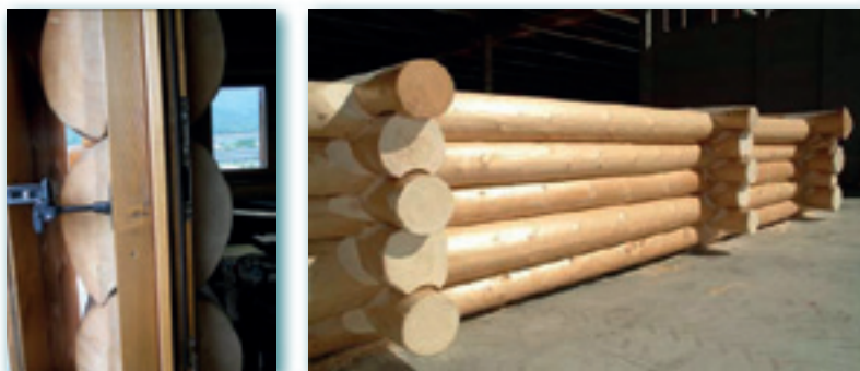
Figura 14 - Abitazioni in legno costruite con sovrapposizione di tronchi di abete grezzo tondo (tipo Blockhaus). Esempio di un'abitazione Uni-Cà 18 [Fotografie dell'autore]
