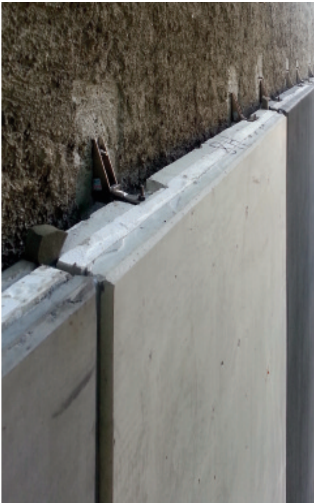
A sinistra, fase di montaggio dei pannelli prefabbricati. A destra, fase di finitura del giunto tra pannelli.
