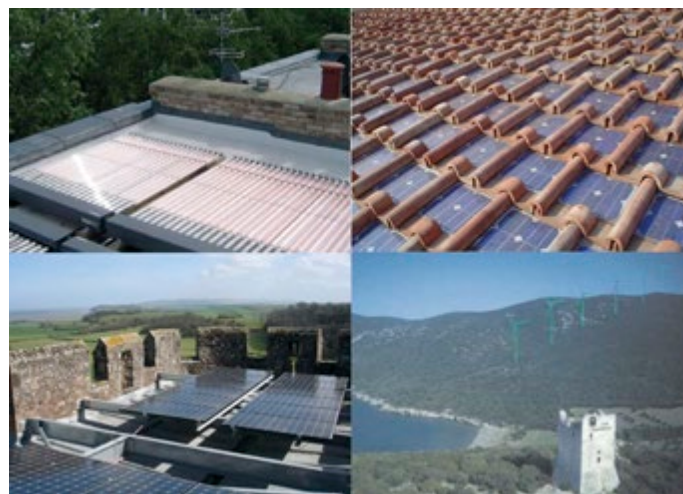
03 | Approccio conservativo statico: da dx in alto, senso orario: Tegole fotovoltaiche (fonte: http://www.fornacefonti.it ), Simulazione cromatismo pale eoliche per mitigazione ambientale (fonte: Regione Toscana, Linee guida per la valutazione dell'impatto ambientale degli impianti eolici, 2004, p. 99), Pannelli solari nascosti sulla copertura del Castello di Dunster (fonte: http://hc.historicengland.org.uk , © National Trust and Alan Watson), Pannelli solari non visibili sul tetto piano di Beaufort Gardens, Londra (fonte: English Heritage, Microgeneration in the Historic Environment , 2012, p. 3, courtesy of Royal Borough of Kensington and Chelsea)
