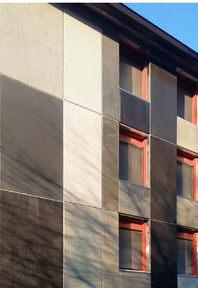
Fig. 3: Prospetto est post riqualificazione Fig. 3: East elevation after the refurbishment
