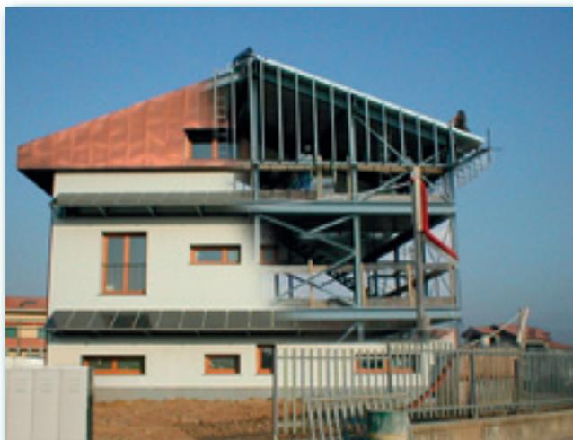
Figura 2. La prima Passivhaus costruita in Italia si trova a Chignolo d'Isola (progettisti: Brandolini Valdameri studio associato; impresa costruttrice: Vanoncini S.p.A.). L'edificio è basato sulla tecnologia Struttura / Rivestimento ed è interamente assemblato a secco (foto Vanoncini S.p.A., rielaborata dall'autore).
