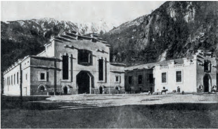
Centrale idroelettrica di Mese, Chiavenna (SO)
