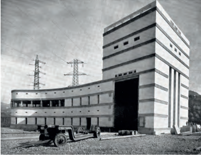
Stazione di trasformazione elettrica di Morigallo a Genova
