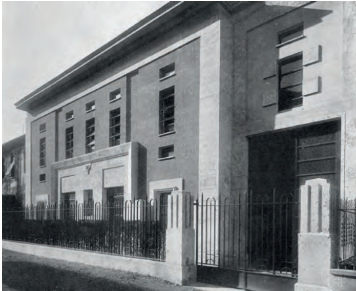
Cabina di trasformazione via Gallina 9, Milano
