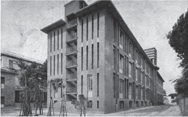
Ampliamento dei dormitori della Colonia Ettore Motta di Marina di Massa
