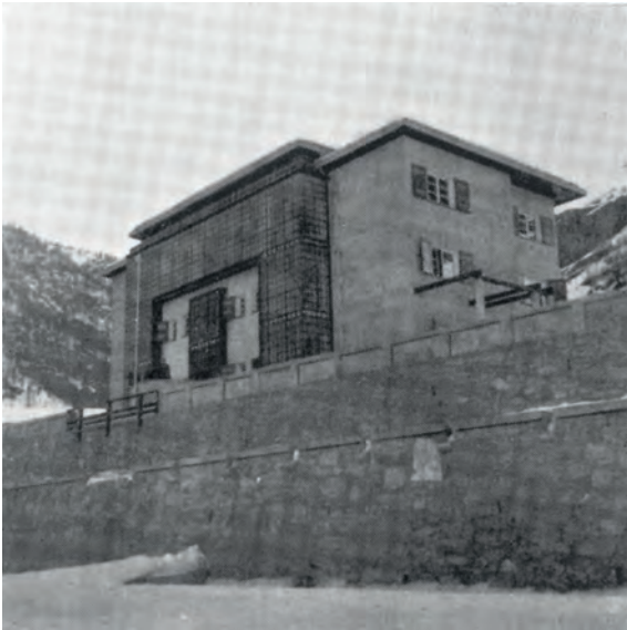
Casa d'abitazione di Casteldelfino
