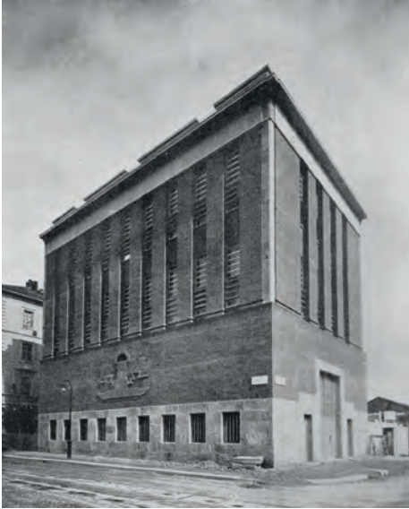
Cabina di trasformazione via Troya 15, Milano
