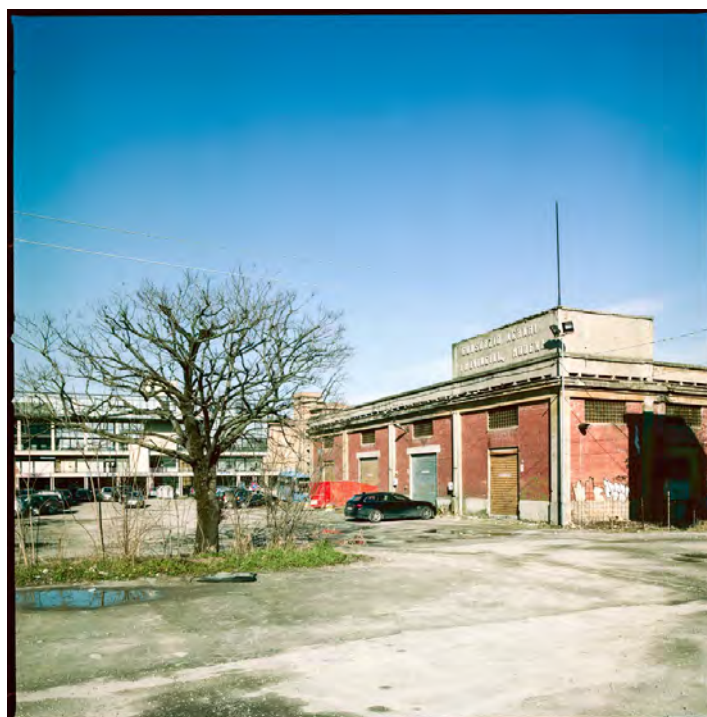
Figura 1 | L'ex-consorzio agrario, localizzato in pieno centro urbano, a fianco della stazione Modena-Sassuolo. Fonte: fotografia di Andrea Pirisi.
