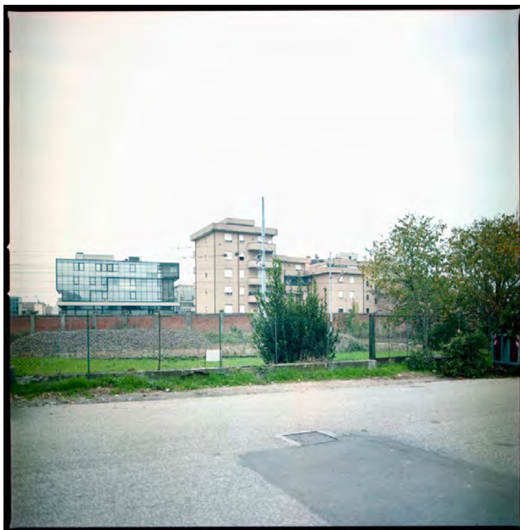
Figura 3 | Adiacente alla ferrovia per Modena, un complesso direzionale ha sostituito uno dei primi stabilimenti ceramici del distretto. La sovrapproduzione di uffici è all'origine dell'attuale e generalizzato fenomeno di sottoutilizzo degli spazi terziari. Fonte: fotografia di Andrea Pirisi.
