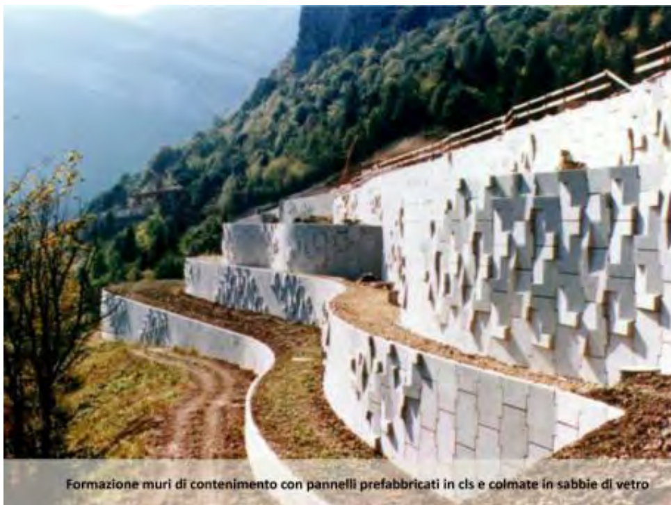
Figura 5 | Esempio d'uso di inerti riciclati nella formazione di manufatti prefabbricati e consolidamento di crinali.
