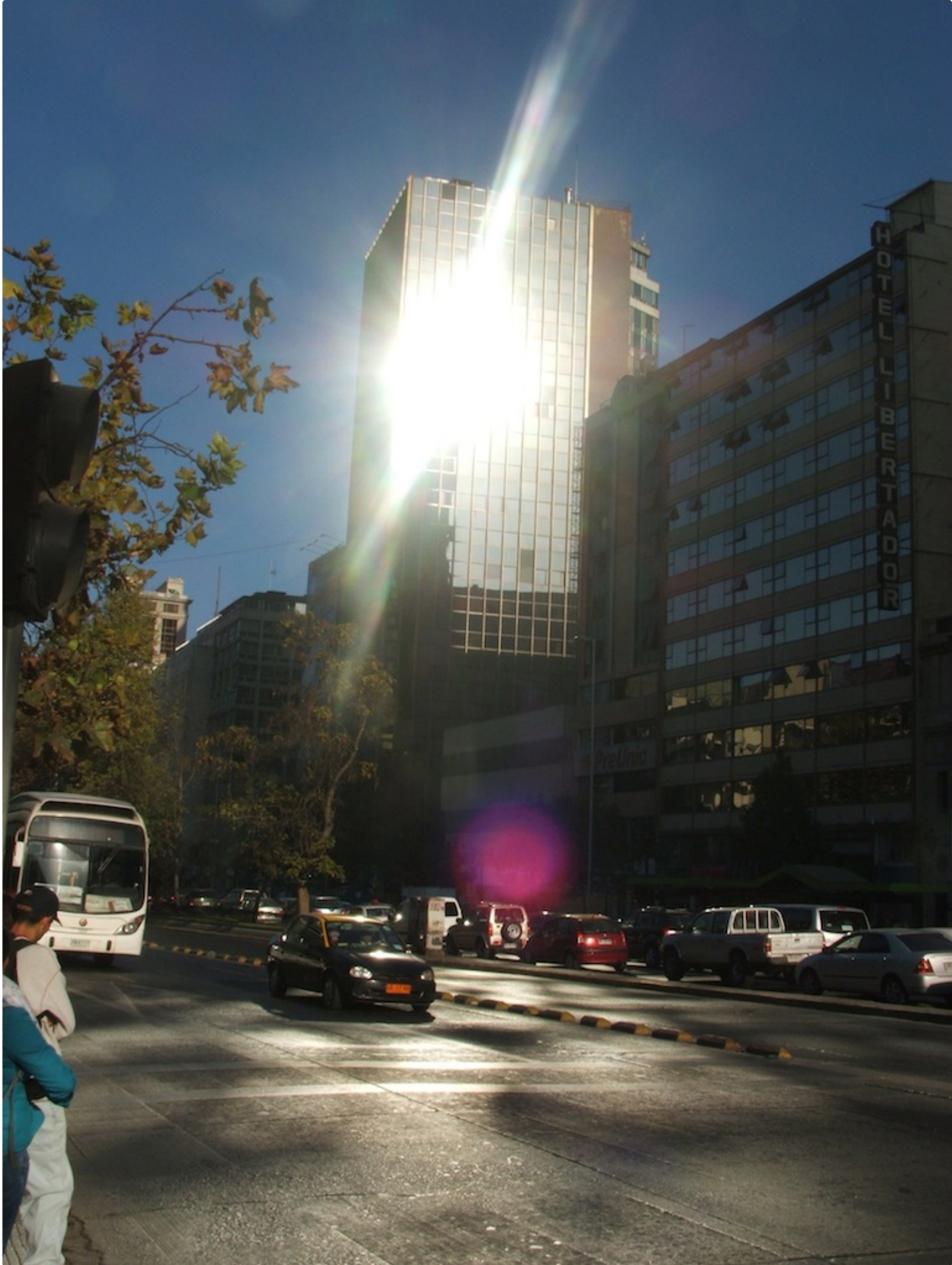
Radiazione riflessa dalla facciata di un edificio con finitura specchiante in un ambiente urbano
