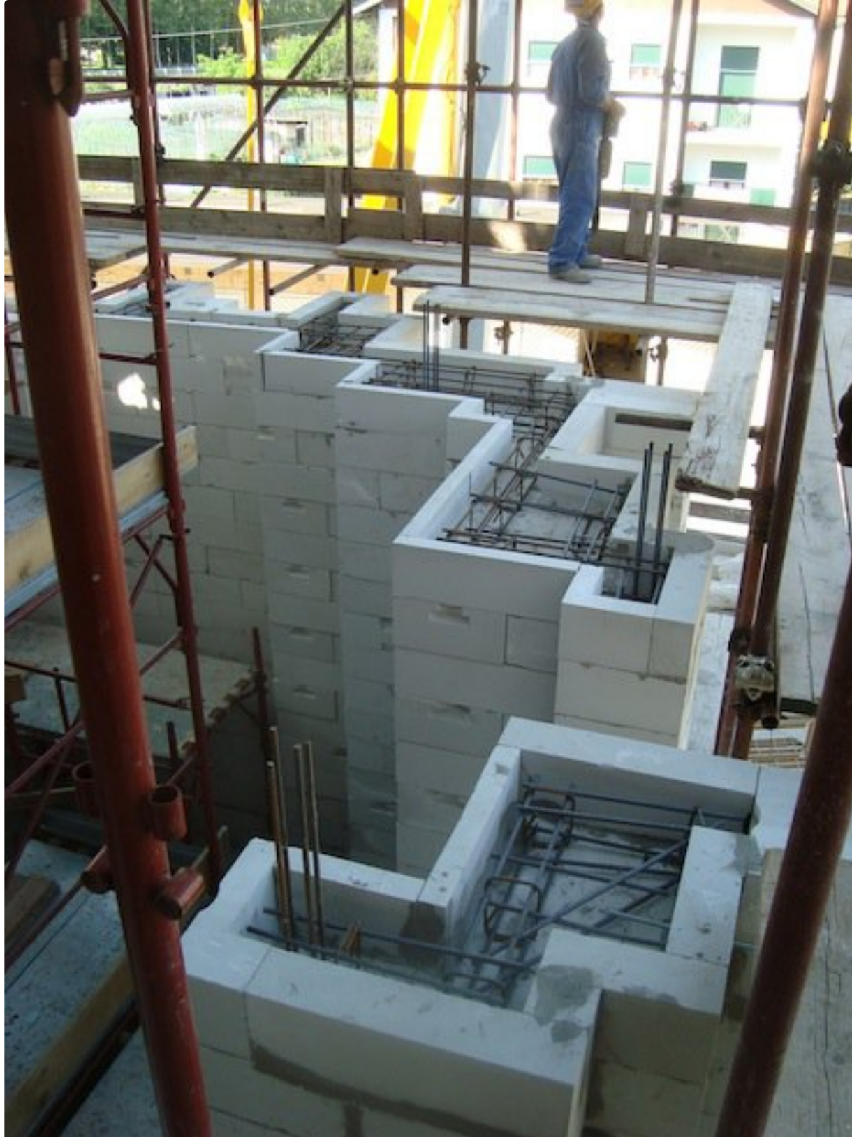
Costruzione del corpo tecnologico
