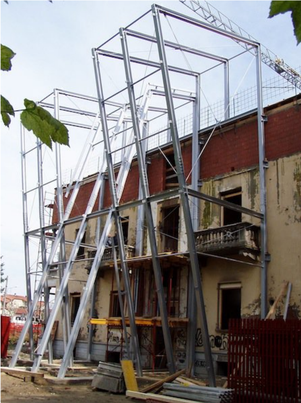
Fase di realizzazione della serra addossata
