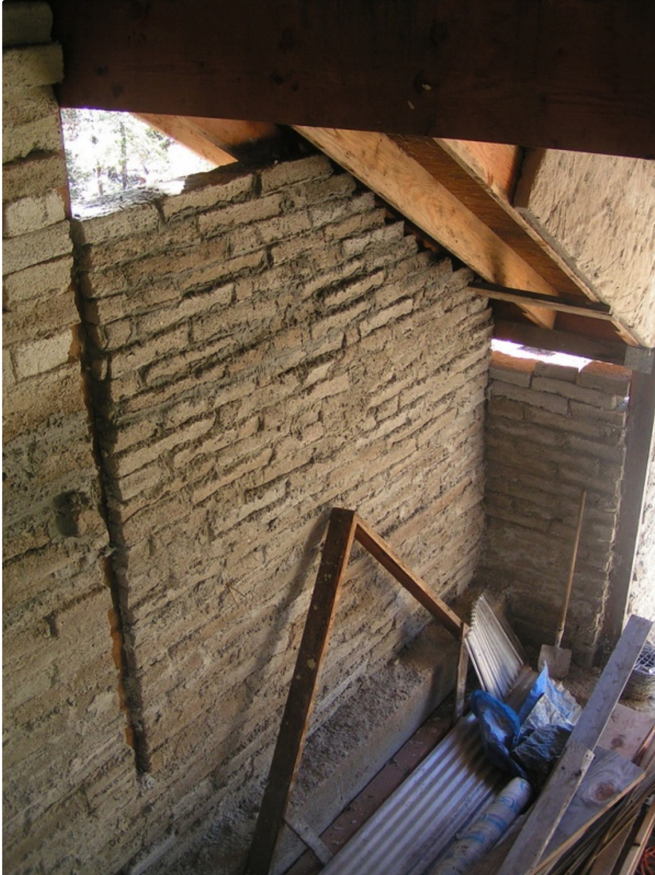
Interno di un edificio in papercrete, California
