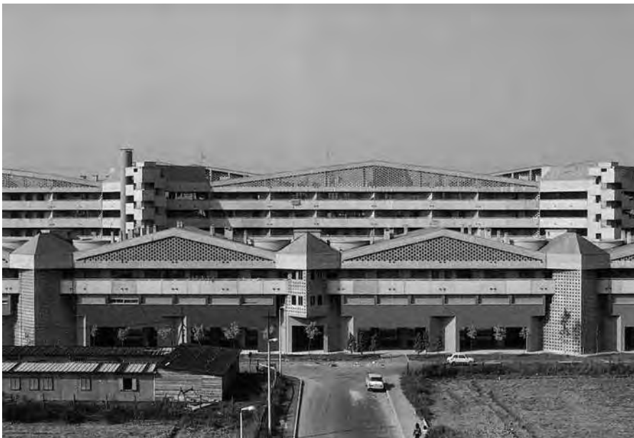
16. G. Canella, Quartiere residenziale IACP a Bollate, Milano, 1974-81.
