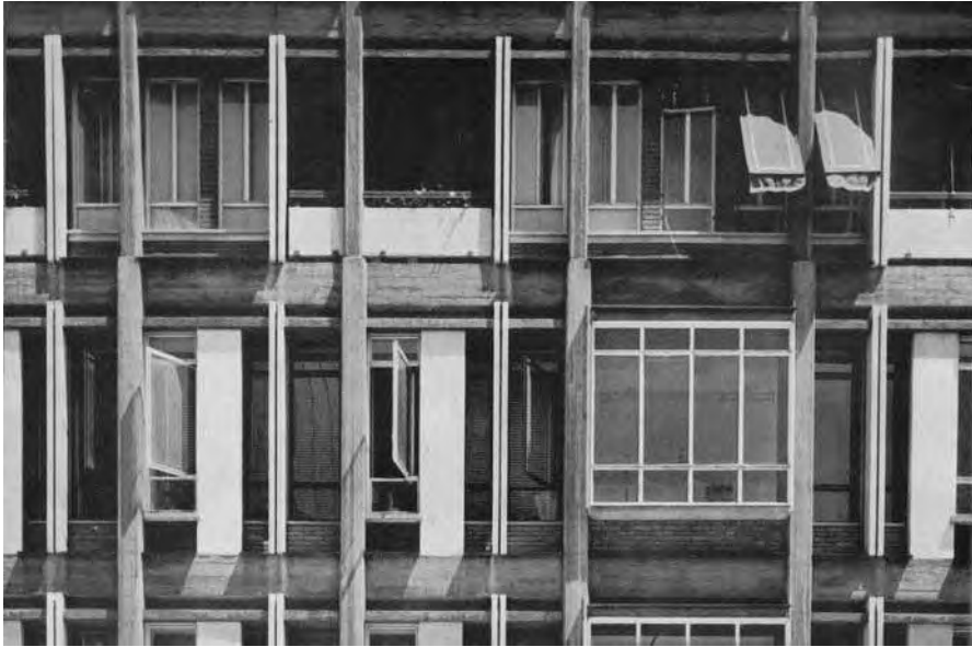
3. G. Samonà, con E. Trincanato, Edificio Inail per uffici e abitazioni, Venezia, 1950-56: particolare di facciata.
