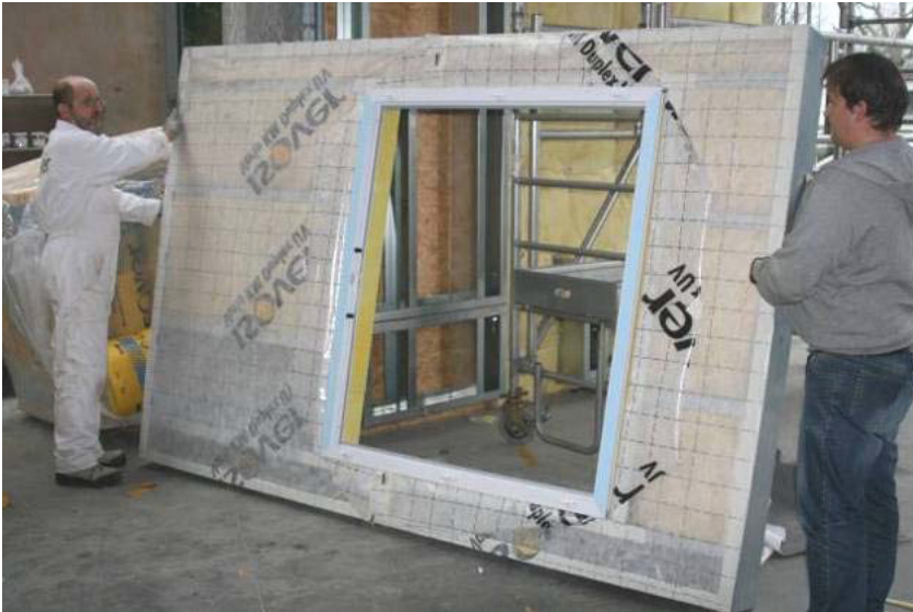
Fig. 4 Prototype façade module
