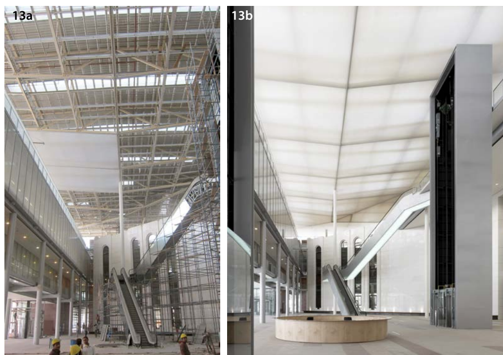
Fig. 13 – Vista durante il cantiere e ad opera conclusa di uno degli atrii che si collocano tra il vecchio e il nuovo, ben illuminati dalla luce zenitale diffusa omogeneamente dal sistema tessile tesato sul soffitto (©Bollinger + Grohmann)
