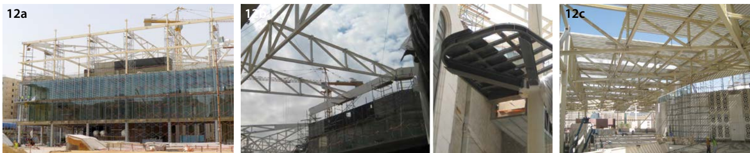
Fig. 12 – Il cantiere: la costruzione della struttura di facciata e del solaio di copertura, in cui si individuano i tagli lasciati per i lucernari (©Bollinger + Grohmann, Maffeis Engineering).
