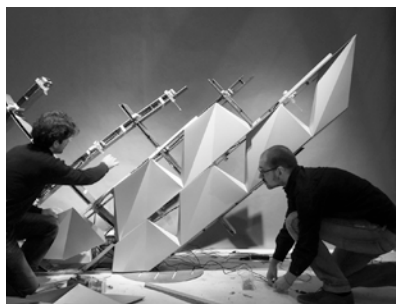
F06-07 | INDEXLAB "Shivers" 2012, Politecnico di Milano – Nieder – EverElettronica. Prototipo di facciata unico nel suo genere, progettato con processi algoritmici e logiche parametriche, realizzato con tecnologie di taglio - piega a controllo numerico e dotato di sensori e attuatori per adattarsi all'ambiente.
