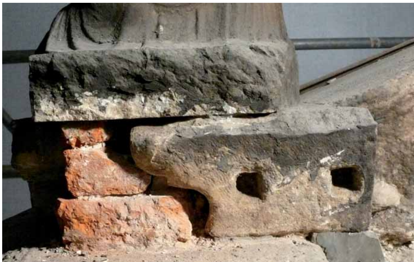
Fig. 8. Altare della Presentazione: la base che sostiene la figura di Santa subito accanto al San Paolo è un evidente caso di reimpiego: si tratta di un frammento di cornice, nel punto dell'angolo, voltato e calzato con mattoni.
