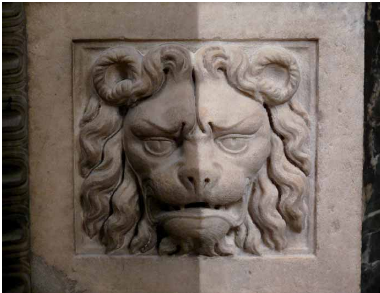
Fig. 3. Altare di san Giuseppe: l'immagine pone in evidenza la differenza tra la parte già sottoposta a pulitura e la restante zona che è ancora annerita da depositi di natura grassa.
