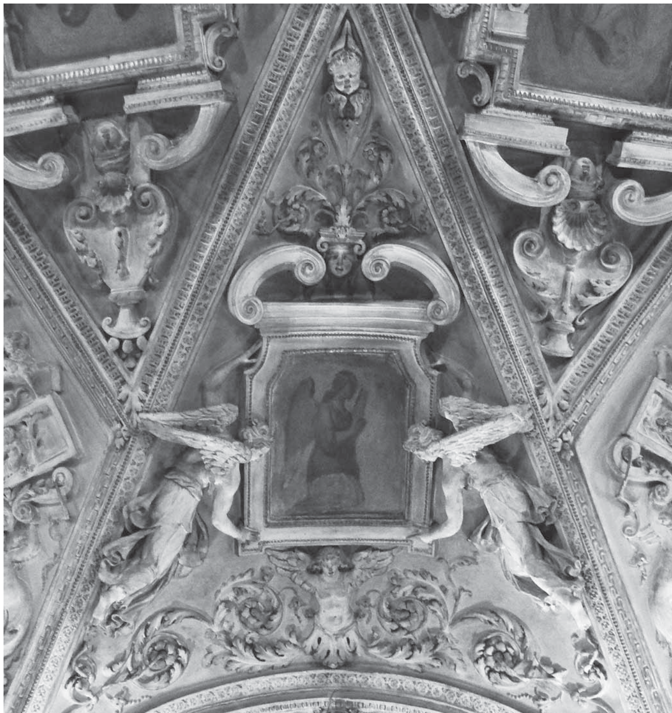
Fig. 6. Scurolo, Milano, Duomo, particolare delle decorazioni della volta.
