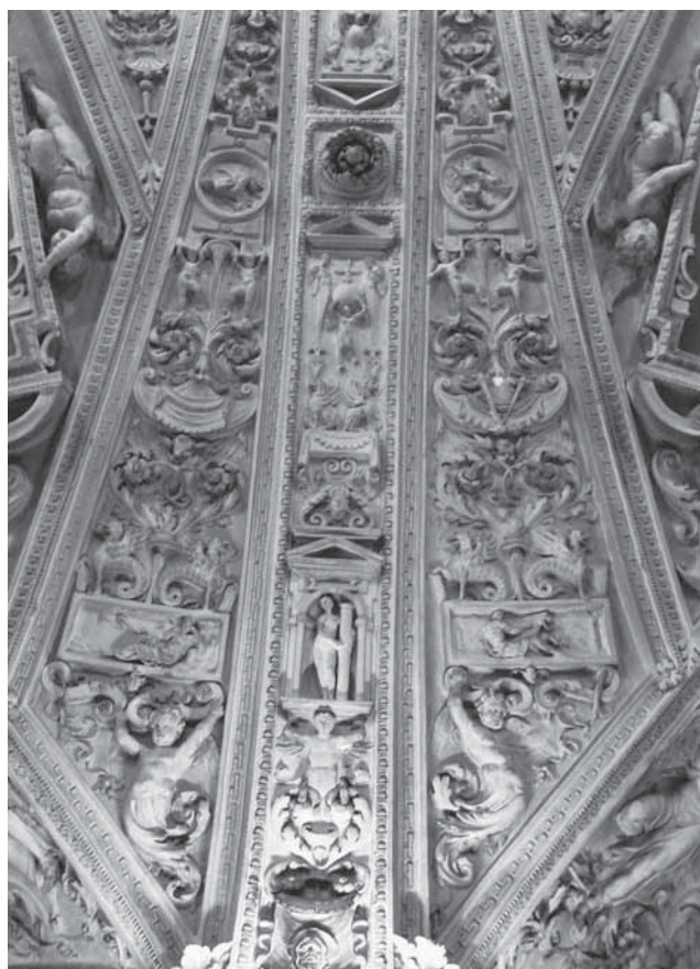
Fig. 4. Scurolo, Milano, Duomo, particolare delle decorazioni della volta.
