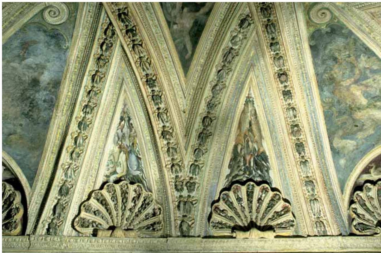
Fig.10. La sala dei Pesci o di Nettuno nel Palazzo Ducale di Mantova.
