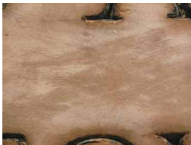
Fig. 5. Monumento Medici: sotto il deposito incoerente che offuscava la superficie scultorea si conservava una pellicola composta da una cera di origine vegetale di cui si leggeva chiaramente l'andamento impresso alle pennellate al momento della stesura.
