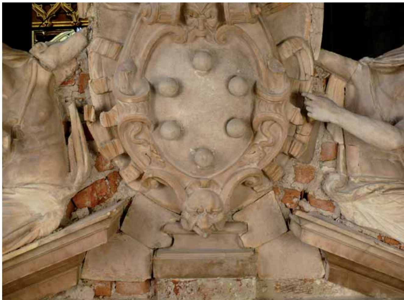
Fig. 6. Monumento Medici: lo stemma centrale sul coronamento è stato rimaneggiato in seguito alla caduta di un frammento di marmo dal finestrone: è stato rialzato di circa 10 cm inserendo un mattone di taglio per base; quattro lastre di Candoglia tamponano i vuoti che si creavano nel disegno originale.
