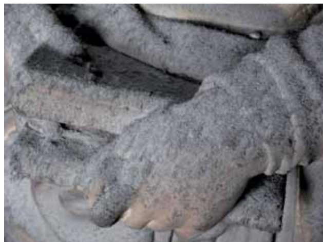
Fig. 2. Altare di san Giuseppe: i depositi, composti principalmente di particolato atmosferico contenente sali solubili, erano di una sorprendente consistenza, dovuta in gran parte ai fumi delle candele. In ragione della posizione difficilmente raggiungibile, le sculture e le decorazioni del coronamento mostravano una stratificazione di deposito assai più spessa.
