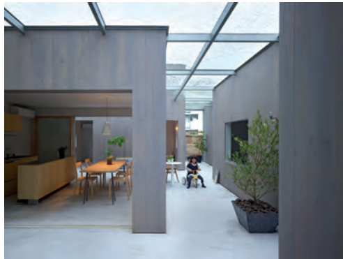
Figg. 291, 292 Suppose Design Office, house in Buzen, Fukuoka, Giappone, 2009 Il soffitto trasparente è utilizzato come elemento unificatore dei volumi (cucina, bagni, camere da letto) di cui si compone l'abitazione. È appoggiato a un reticolo metallico e connota gli spazi di uso comune attraverso l'ingresso diretto della luce in uno stretto rapporto con il cielo
