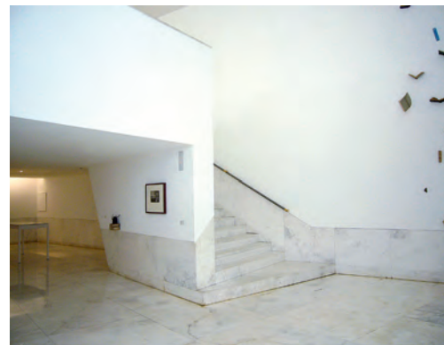
Fig. 312 Alvaro Siza, Centro Galego di Arte Contemporanea, Santiago de Compostela, Spagna, 1988-1993 Una delle variabili nel progetto del raccordo tra pavimento e parete è quella delle dimensioni dell'elemento di congiunzione. Se da un lato è possibile minimizzare l'altezza del battiscopa, in particolare nelle soluzioni a incasso, dall'altro è possibile risvoltare il piano di pavimento di una misura tale da trattare lo zoccolo come una sorta di boisèrie. È questa la soluzione adottata da Siza, che risvolta il piano in marmo del pavimento a quota corrimano, stabilendo così un rapporto di continuità tra le due superfici.
