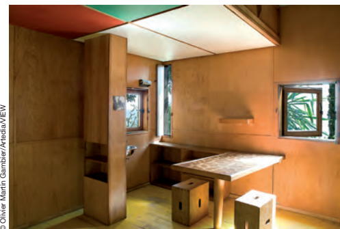
Fig. 279 Le Corbusier, Cabanon, Roquebrune Cap Martin, Francia, 1951 - 1952 Il soffitto del Cabanon, realizzato in pannelli di legno come tutto l'interno, è concepito come un piano orizzontale articolato su più livelli in modo da essere utilizzato anche come deposito. L'articolazione spaziale è sottolineata anche dalla finitura di superficie che disegna una griglia di rettangoli colorati.
