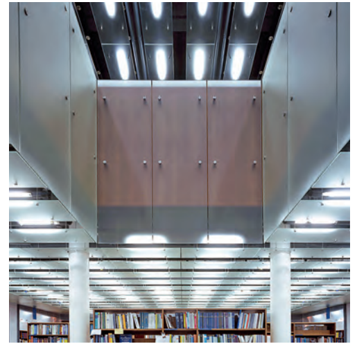
Fig.305 Mauro Galantino, Libreria Egea Bocconi, Milano, 2001 Il controsoffitto è disegnato secondo una trama a fasce parallele di pannelli in vetro satinato che, pur lasciando intravedere la struttura soprastante, creano un effetto di luce diffusa su tutto lo spazio della libreria.
