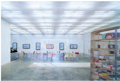
Figg. 306,307 SANA A, New Museum of Contemporary Art New York, USA, 2003-2007 Nel piano terra del New Museum, un controsoffitto luminoso e leggero in lamiera forata bianca si contrappone alla lastra liscia piena del pavimento
