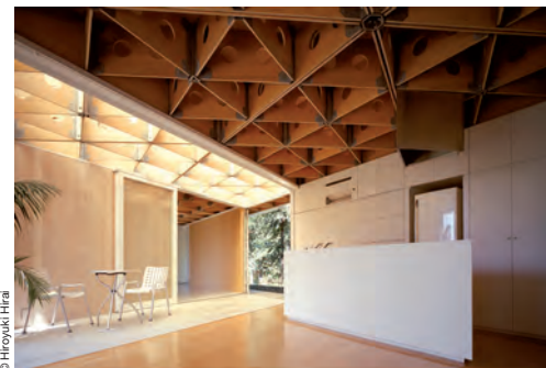
Figg. 276, 277 Shigeru Ban, Veneer Grid Roof House, Chiba, Giappone, 2001 La struttura cassettonata, più volte sperimentata da Shigeru Ban anche con materiali come il cartone, è qui risolta attraverso l'utilizzo del legno multistrato. Impostate su una griglia di triangoli equilateri, le travi sono unite da giunti in alluminio. L'intera copertura appoggia su un sistema di contenitori fissi che definiscono il perimetro della casa.
