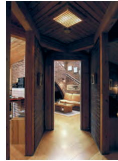
Figg. 251, 252 Sverre Fehn, Casa Bodtker I, 1965 - 1967 e II, 1982 - 1985, Oslo, Norvegia I listoni in legno, posati tradizionalmente, sono arricchiti dal dettaglio del tondino in legno che nasconde la vite di fissaggio al supporto sottostante
