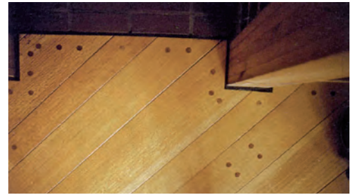
Figg. 251, 252 Sverre Fehn, Casa Bodtker I, 1965 - 1967 e II, 1982 - 1985, Oslo, Norvegia I listoni in legno, posati tradizionalmente, sono arricchiti dal dettaglio del tondino in legno che nasconde la vite di fissaggio al supporto sottostante
