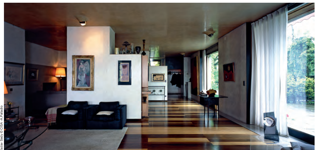
Fig. 250 Posa parquet prefinito flottante. Si tratta di un sistema di posa che non richiede né colla né chiodi. Si realizza attraverso un incastro maschio-femmina sul lato lungo delle lastre ed è di facile rimozione ed eventualmente riposizionabile. Viene appoggiato direttamente sul pavimento sottostante con la sola interposizione di un materassino isolante in poliuretano che ammortizza eventuali piccoli dislivelli e riduce il rumore di calpestio.
