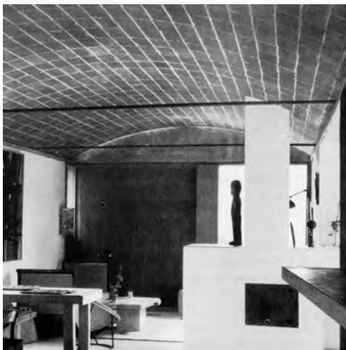
Figg. 284-286 Le Corbusier, Maison Jaoul, Parigi, 1954 - 1956 Lo spazio interno della Maison Jaoul è coperto da volte 'catalane', con mattoni a vista. Queste volte sono proprie di una tradizionale tecnica catalana di costruzione che consiste nel coprire uno spazio con mattoni affiancati disposti di piatto, cioè che mostrano a vista la superficie maggiore. Nel primo strato i mattoni sono uniti con gesso. La messa in opera non necessita di casseformi, ma solo di dime di controllo geometrico, in quanto il gesso ha un'asciugatura molto rapida e aumenta di volume in fase di presa mettendo in pressione i singoli componenti e aumentando la resistenza dell'insieme. Al primo "foglio" sono sovrapposti da un minimo di uno a un massimo di quattro strati di mattoni legati con malta di cemento o calce e con giunti sfalsati rispetto al sottostante. L'intero pacchetto ha spessori molto sottili che vanno dai 7 ai 11 cm.
