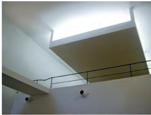
Figg. 299 - 301 Alvaro Siza, Centro Galego di Arte Contemporanea. Santiago de Compostela, Spagna, 1988 - 1993 Il controsoffitto può essere progettato come un piano orizzontale staccato dal solaio attraverso elementi distanziatori. La fonte luminosa, generalmente nascosta nell'intercapedine, consente di accentuare l'effetto di sospensione anche in mancanza di luce naturale. Nel Centro Galego il controsoffitto è un piano appeso in corrispondenza degli angoli che, direzionando la luce verso il soffitto, permette di illuminare l'ambiente attraverso un principio di riflettenza.
