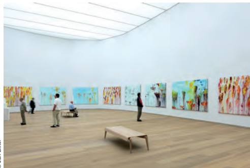
Fig.308 Sauerbruch Hutton, Museo Brandhorst, Monaco di Baviera, Germania, 2009 I soffitti delle sale del Museo Brandhorst sono realizzati con Barrisol, il sistema industrializzato di soffitti leggeri attualmente più diffuso. Si tratta un controsoffitto realizzato con teli ininfiammabili in PVC che, dopo il fissaggio a supporti di alluminio estruso ancorati alle pareti, vengono tesi con il calore. È un sistema estremamente flessibile in quanto i profili sono di moltissimi tipi, rettilinei, curvi o calandrati, e la membrana si può adattare a qualsiasi forma, mantenendo inalterate le sue caratteristiche tecniche. Utilizzato principalmente in spazi espositivi e in edifici pubblici, viene spesso integrato da un sistema di illuminazione che lo trasforma in un grande diffusore di luce.
