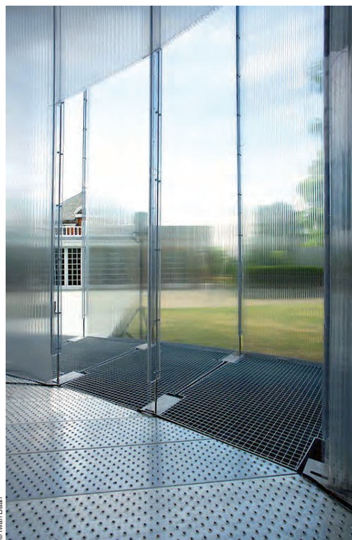
Fig. 267 Rem Koolhaas e Cecile Balmond, Serpentine Gallery, Londra, UK, 2006 In questo padiglione temporaneo, Koolhaas utilizza per il pavimento moduli in lamiera stirata, montati su una struttura prefabbricata
