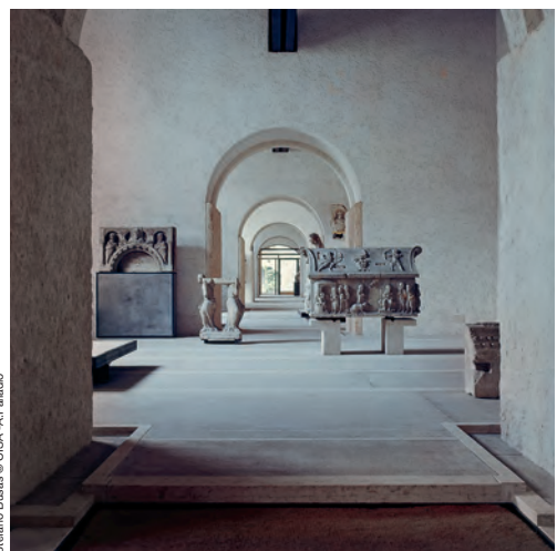
Fig. 312 Alvaro Siza, Centro Galego di Arte Contemporanea, Santiago de Compostela, Spagna, 1988-1993 Una delle variabili nel progetto del raccordo tra pavimento e parete è quella delle dimensioni dell'elemento di congiunzione. Se da un lato è possibile minimizzare l'altezza del battiscopa, in particolare nelle soluzioni a incasso, dall'altro è possibile risvoltare il piano di pavimento di una misura tale da trattare lo zoccolo come una sorta di boisèrie. È questa la soluzione adottata da Siza, che risvolta il piano in marmo del pavimento a quota corrimano, stabilendo così un rapporto di continuità tra le due superfici.
