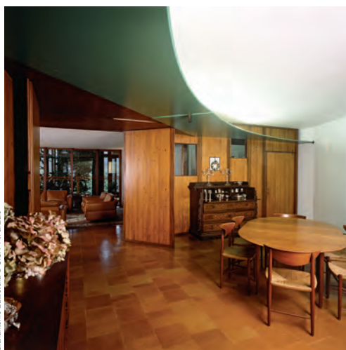
Fig. 257 Carlo Scarpa, Casa Veritti, Udine, 1955 - 1961. Il pavimento è realizzato con mattonelle di cotto rettangolari, di pezzatura e colore variabili, disposti a correre a giunti alternati. La fuga è colorata in pasta e ridotta al minimo spessore.
