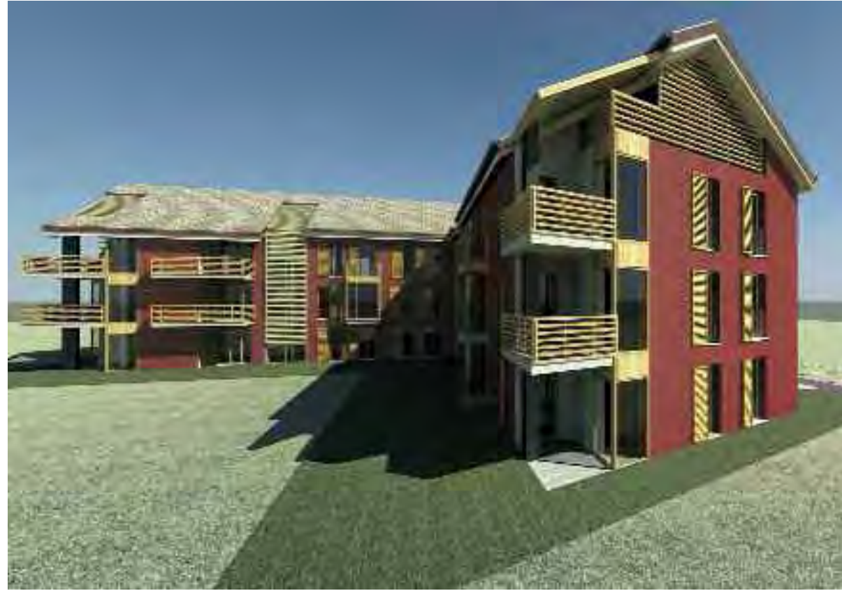
Edificio residenziale. I materiali e il trattamento dei diversi elementi esterni, quali terrazzi, aperture, corpi scala, coperture, danno varietà a volumi semplici e lineari
