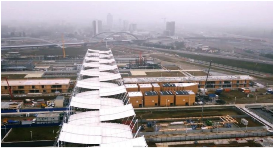
Cantiere EXPO Milano 2015
