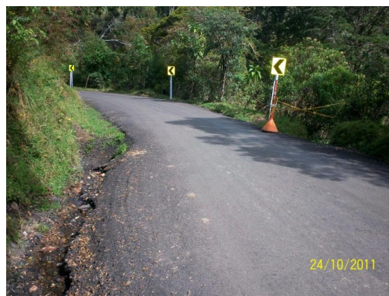
Figura 7. État final de la chaussée en matière de fraisage
