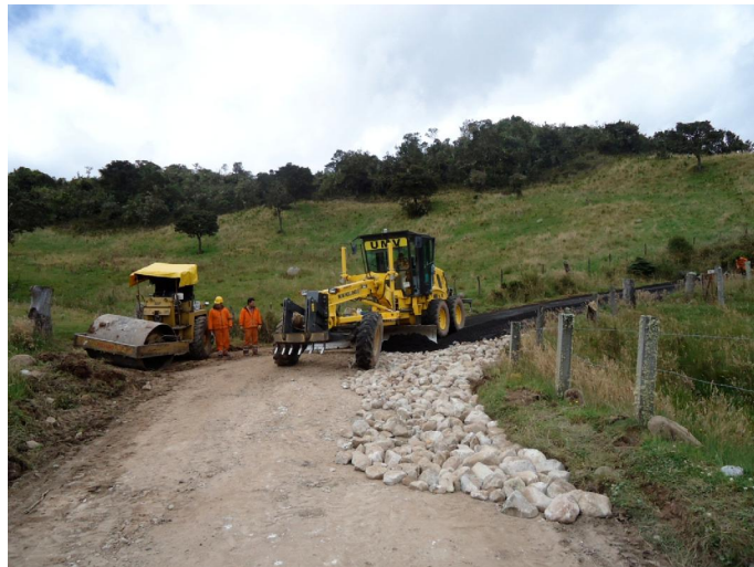
Figura 4. Stabilisation avec revêtement sol saturé en bordure des zones de transit.
