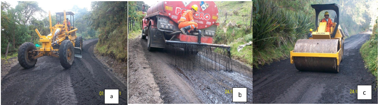
Figura 5. Machines utilisées dans la mise en place de la fraise s'est stabilisée. (a) niveleuse, (b) citerne d'émulsion, (c) Vibro-compacteur
