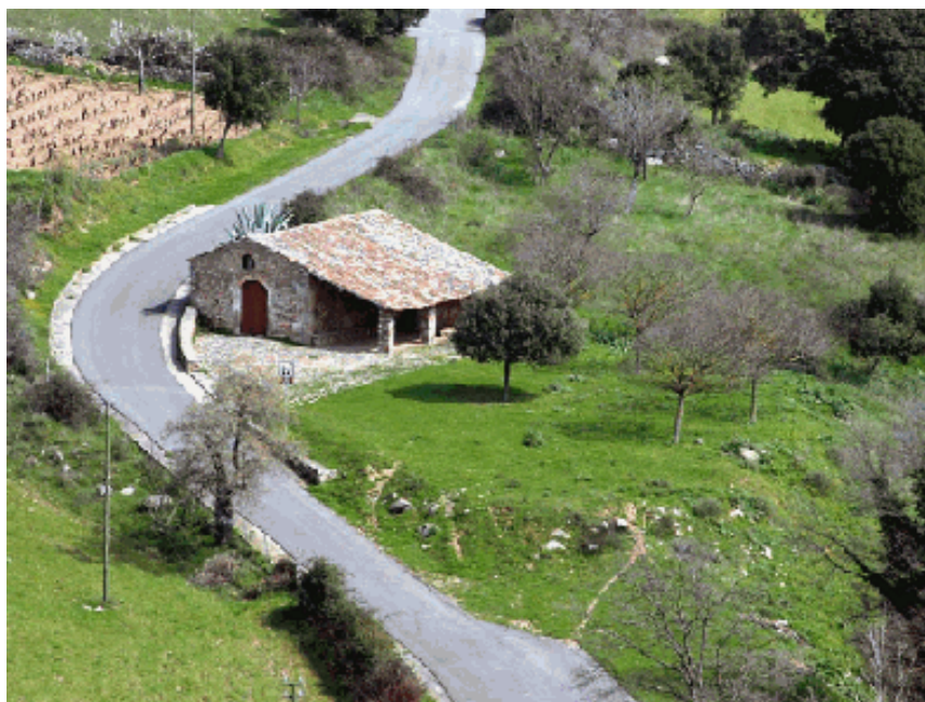
Intervento di riqualificazione di una chiesa campestre integrato con la sistemazione viaria
