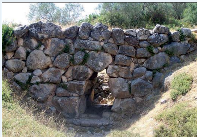
Figura 2 - I resti di un ponte a Porto Heli in Grecia
