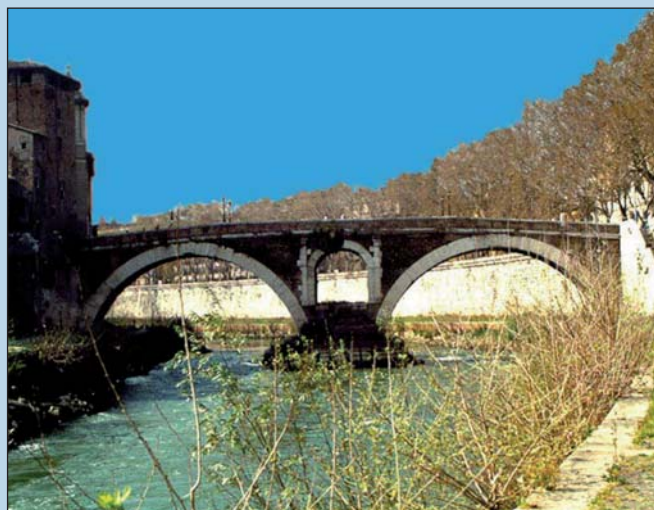
Figura 15 - Il ponte Fabricio a Roma
