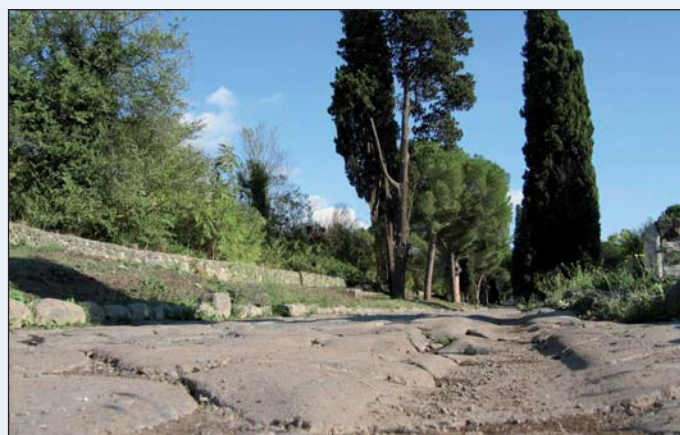
Figura 3 - La Via Appia a Sud di Nemi: un esempio di silice strata
