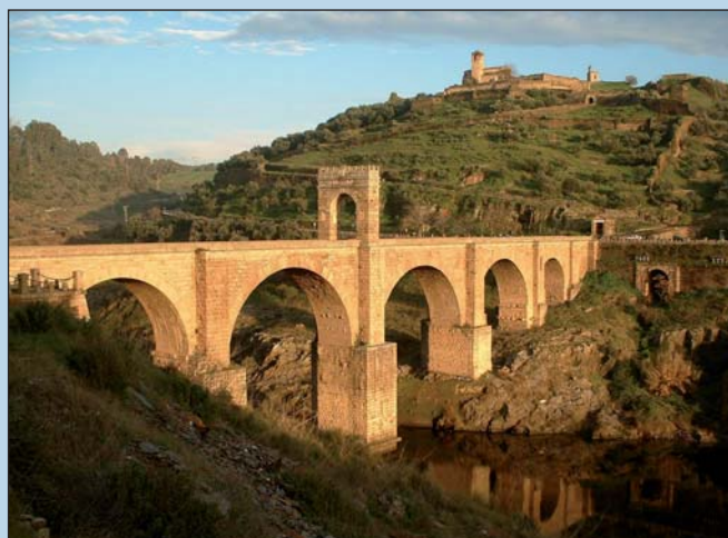
Figura 14 - Il ponte sull'Alcantara in Spagna
