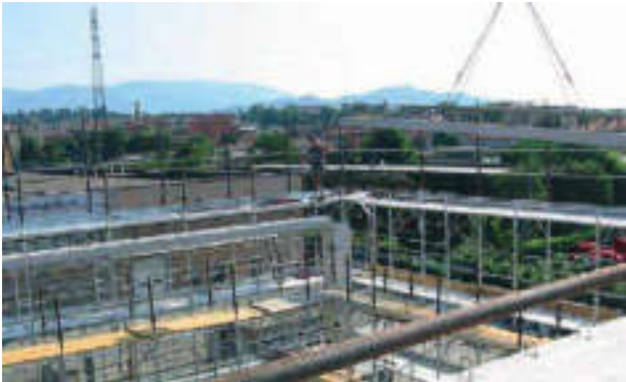
Fig. 4.12: Assemblaggio a secco di un elemento prefabbricato bidimensionale.
