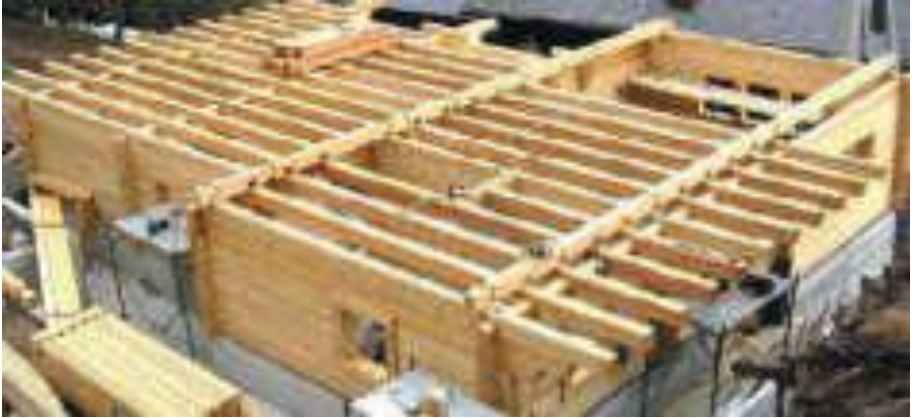
Fig. 4.16: Cantiere per la realizzazione di un edificio con il sistema Blockbau.
