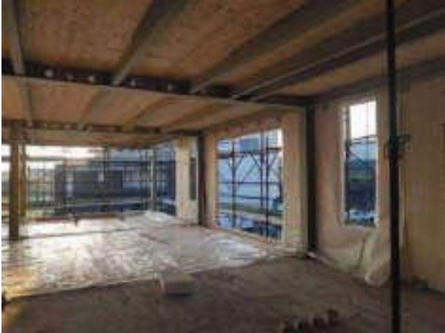
Fig. 4.23: Il sistema costruttivo X-Lam può essere utilizzato per realizzare strutture portanti verticali e orizzontali. Alessandro Volta, edificio ibrido realizzato in X-Lam e acciaio.
