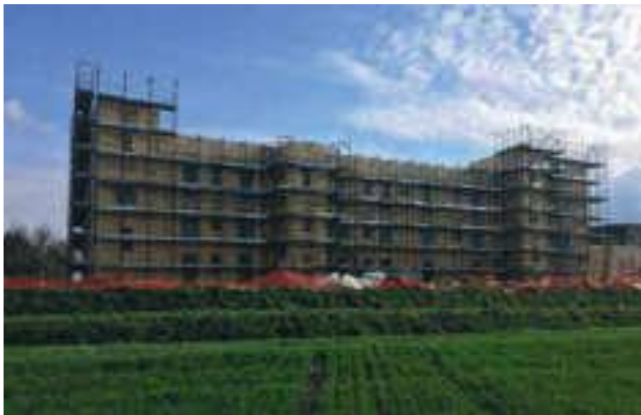
Fig. 4.27: Cantiere del Centro Servizi per Anziani "La Quietè", Fiesso Umbertano (RO). Fonte: X-Lam Dolomiti S.r.l.
