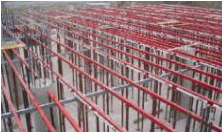
Fig. 4.8: Montaggio del sistema “Alumecono” (cantiere per l’ampliamento del Politecnico di Bovisa, Milano). Fonte: Alsina S.r.l.
