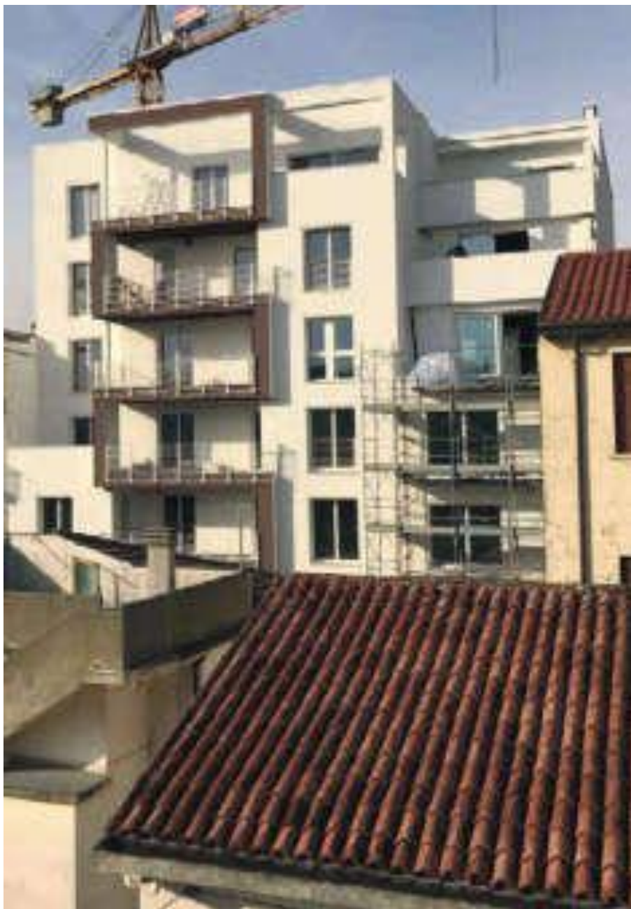
Fig. 4.30: Complesso residenziale ultimato con il sistema X-Lam a Chioggia (VE). Fonte: X-Lam Dolomiti S.r.l.
