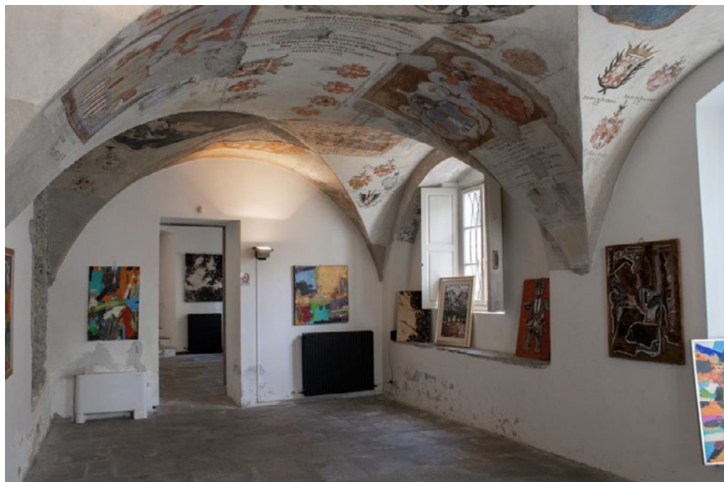
2: Chiavenna (So), Palazzo Pretorio, sala del piano terreno [foto Isabella Balestreri].
