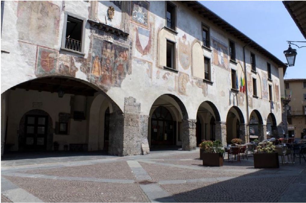
3: Clusone (BG), Palazzo Comunale, facciata sud [foto Isabella Balestreri].
