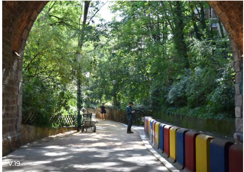
FIGURE V.19 - Les Viaduc des Artes, Paris (France), Coulée verte René-Dumont, 2022 (Source: Claudia Brivio)
