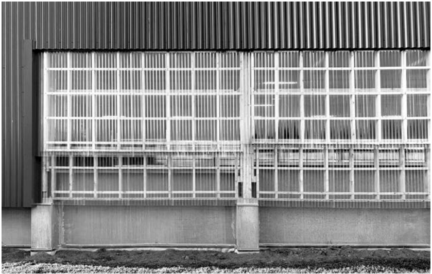
Fig. 03. Edificio sperimentale dell'Unità Herbipôle a Theix, Saint-Genès-Champanelle (FR) (© FAP, 2018-2024)
