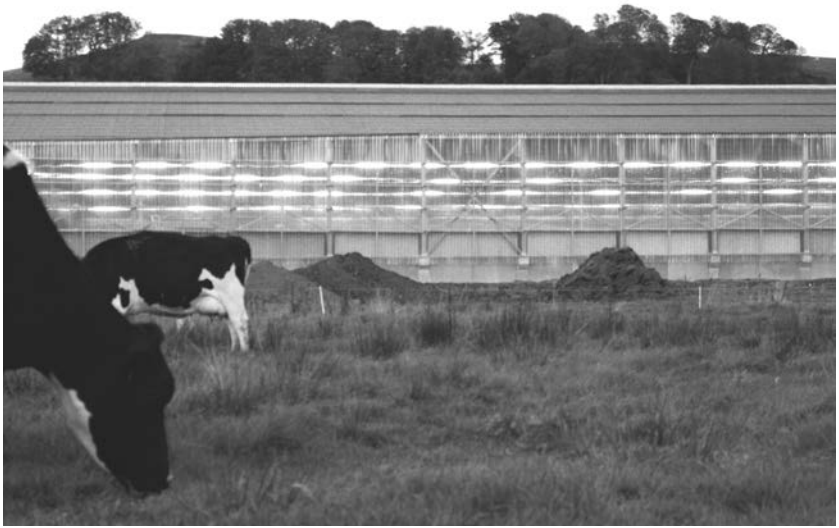
Fig. 02. Edificio per l'allevamento sperimentale a Marcenat (FR) (© FAP, 2011-2014)
