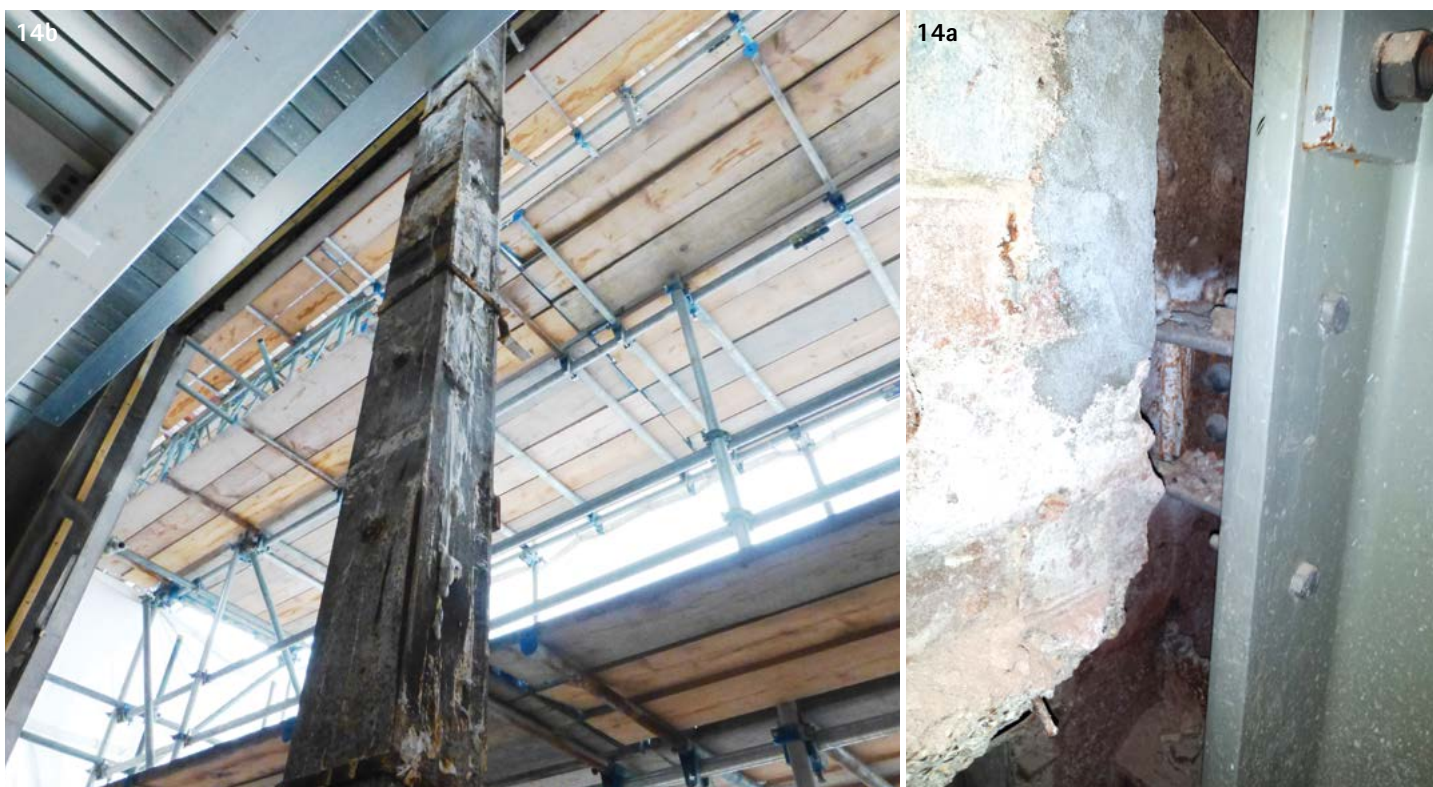
Figg. 14a, 14b – Viste del cantiere nella fase di montaggio della nuova struttura aderente alla struttura della facciata esistente conservata. (©Watermann Group)
