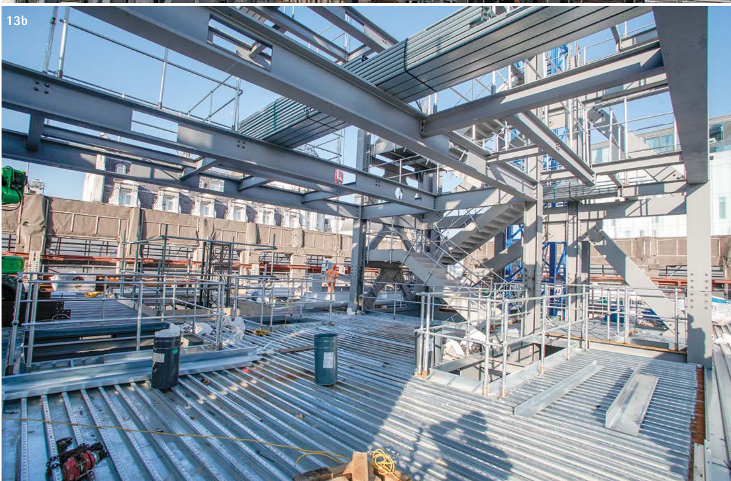
Figg. 13a,13b – Viste del cantiere nelle fasi di costruzione delle strutture centrali e dei solai interpiano. (©Bourne Steel Ltd.)
