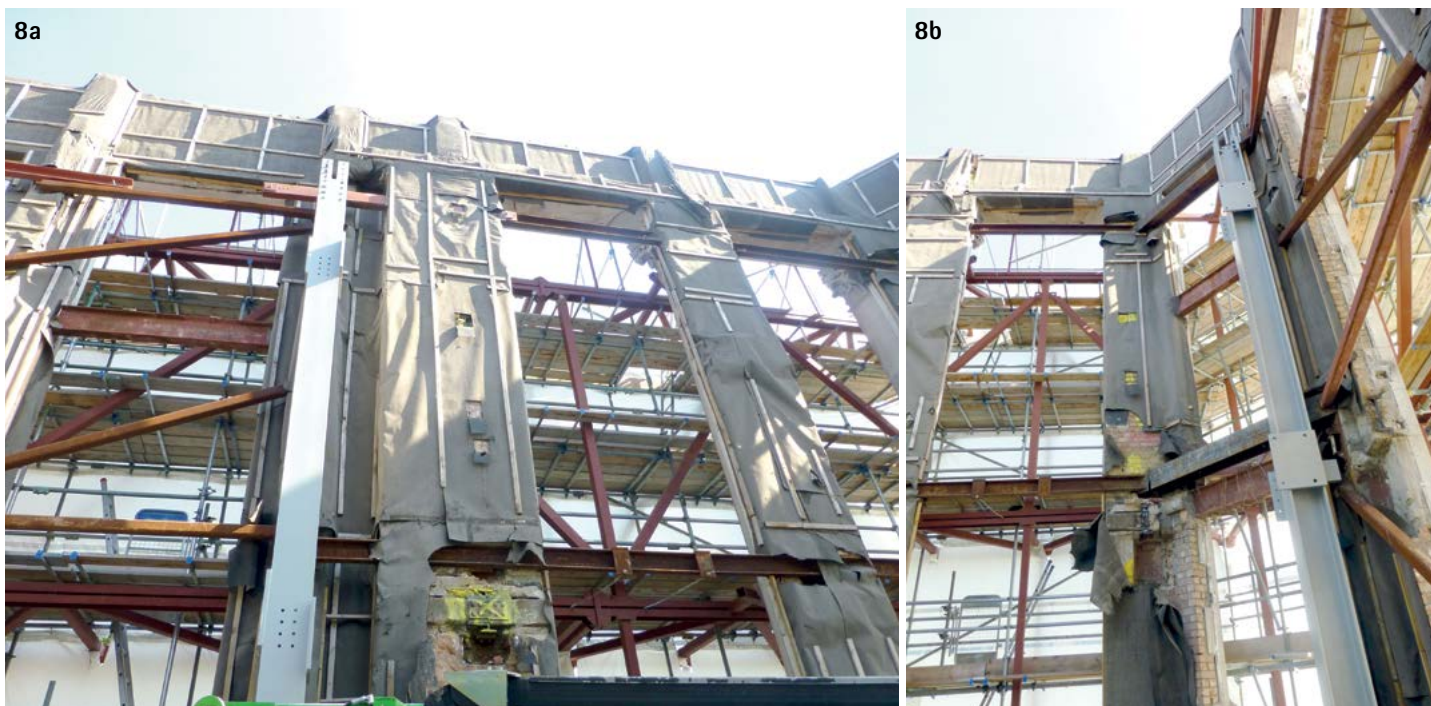
Figg. 8a, 8b – La facciata è stata controventata dall'esterno con delle strutture provvisorie in acciaio durante la fase di demolizione dell'interno, poi coperta con delle guaine impermeabilizzanti di protezione durante tutto il cantiere, e ai vecchi pilastri è stata accoppiata una nuova orditura di pilastri HE in acciaio. (©Watermann Group)
