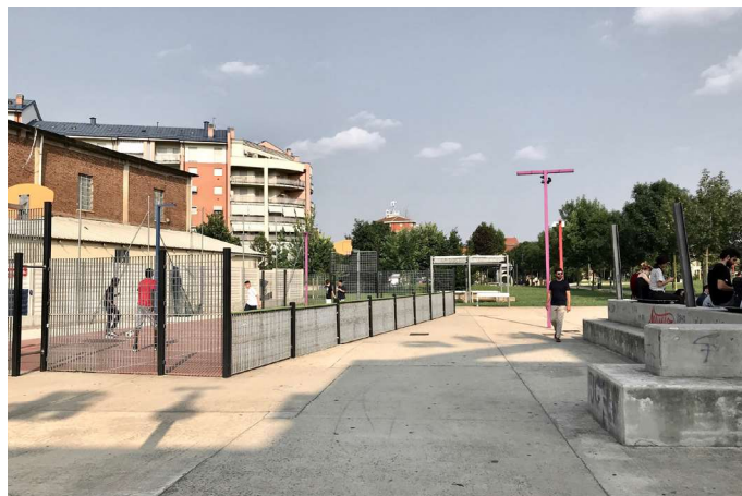
Figura 5. A sinistra: parcheggio antistante la stazione ferroviaria Rebaudengo Fossata (B.Caselli); a destra: Parco Aurelio Peccei, quartiere Barriera Milano (V.R. Zucca).
