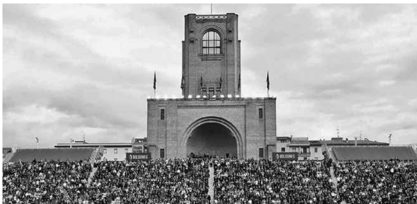
28. Giulio Ulisse Arata, Torre Maratona (1927-1928) nello Stadio Il Littoriale di Bologna, vista interna.
